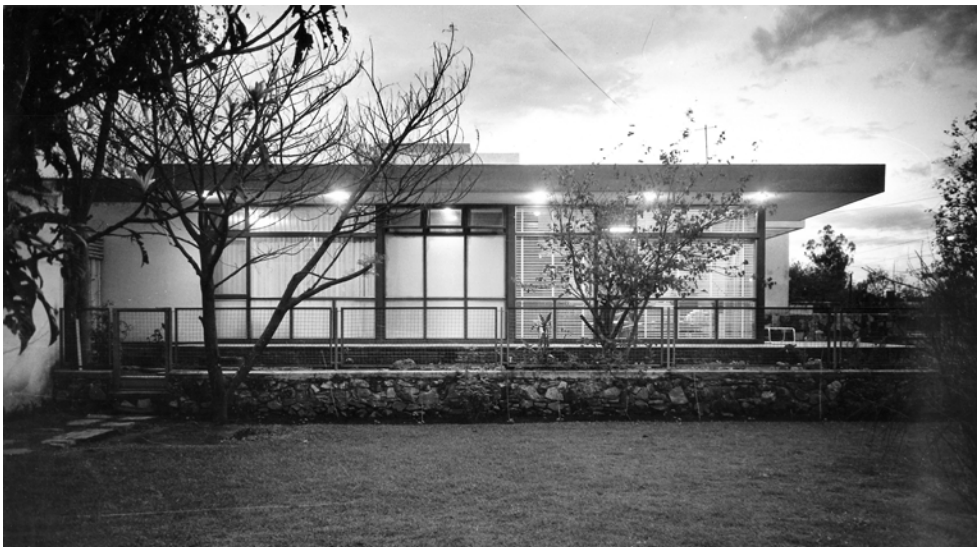
Abb. 117 Casa Ashida, Südseite (Aufnahme vom Nachbargrundstück)
