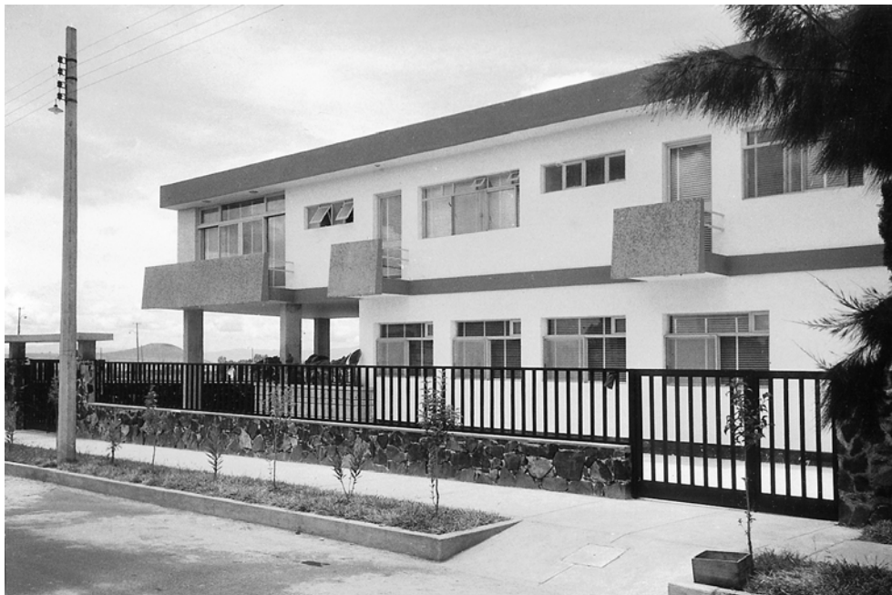
Abb. 94 Haus Plata (1954 - 1956), Straßenansicht
