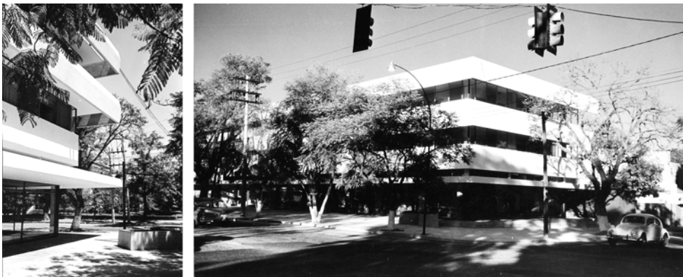
Abb. 106 Bürogebäude Union (1964 – 1965), Straßenansichten
