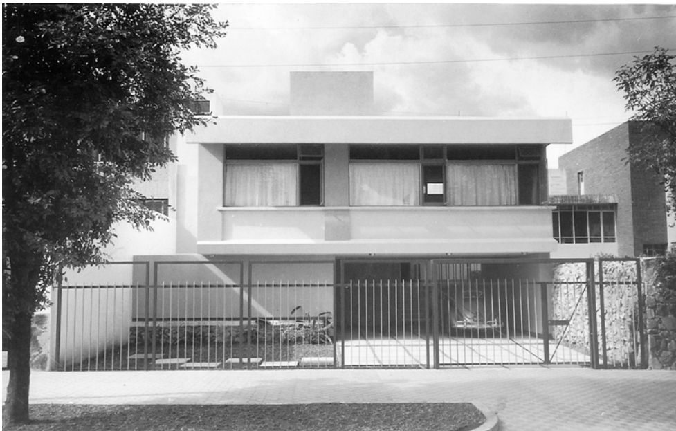
Abb. 97 Haus Hartung (1955 – 1961), Straßenansicht
