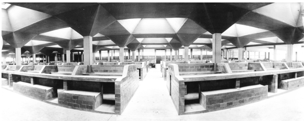
Abb. 129 Mercado Alcalde, Konstruktion der Stände in der Gemüsehalle
