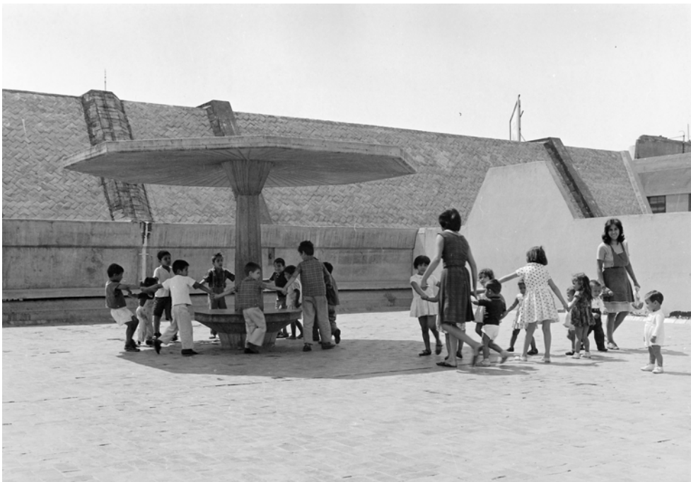
Abb. 130 Mercado Alcalde, Kindergarten, im Hintergrund Dach der Obsthalle
