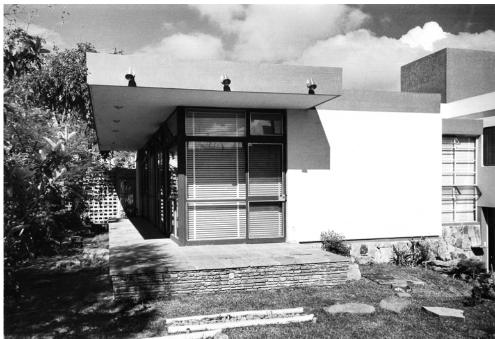
Abb. 119 Casa Ashida, Ostseite
