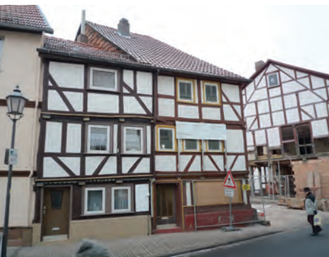
Tankstelle am sogenannten Brühldurchstich (oben) und Leerstand in der Nachbarschaft (unten).
