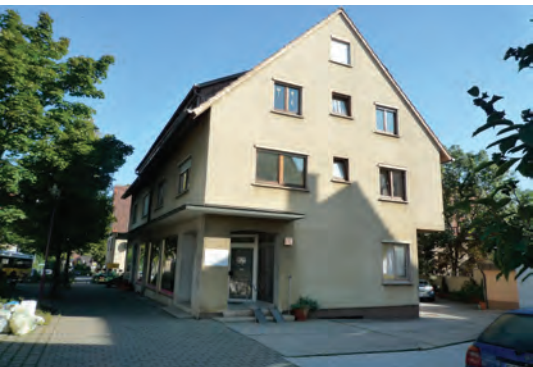
Gemeindepsychiatrisches Zentrum in den Räumen einer ehemaligen Drogerie in Filderstadt-Sielmingen
