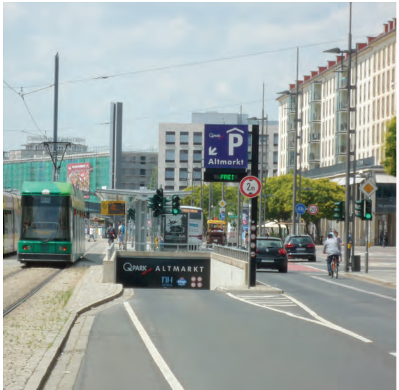
Einfahrt zur Tiefgarage unter dem Dresdner Altmarkt mit rund 470 Stellplätzen
