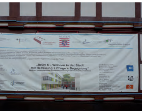
Baufortschritt am Stadthaus-Projekt in Kalenderwoche 46/2010 (oben) sowie Zustand im Dezember 2010 und Bauschild am Stadthaus Brühl 6 (Mitte, unten).
