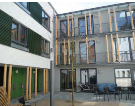
Alter und neuer Zustand des Innenhofs zwischen Vorder- und Hinterhaus.
