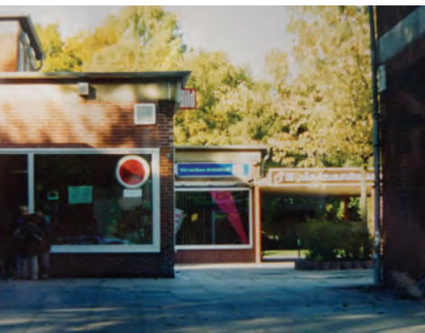
Das Ladenzentrum Riesentrapp im Jahr 2002. Die verbindenden Vordächer sind bereits entfernt. Das Toto-Lotto-Geschäft existiert noch, Spielhalle und Salzgitter Tafel e.V. verändern den Charakter des Landezentrums.
