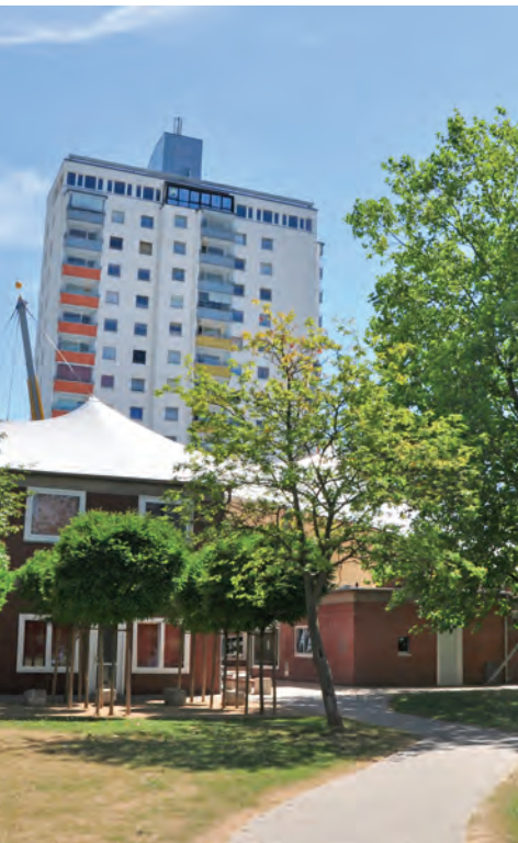
Hochhaus und Ladenzentrum am Riesentrapp nach der Sanierung.
