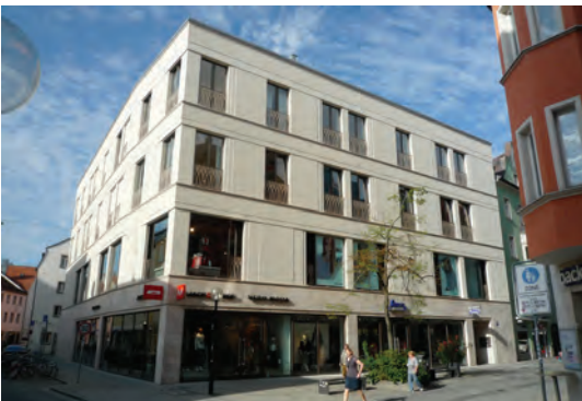
Das ehemalige C&A-Kaufhaus in Regensburg nach dem Umbau. Im Erdgeschoss blieb die Einzelhandelsnutzung erhalten, in den Obergeschossen entstand hochwertiger Wohnraum.
