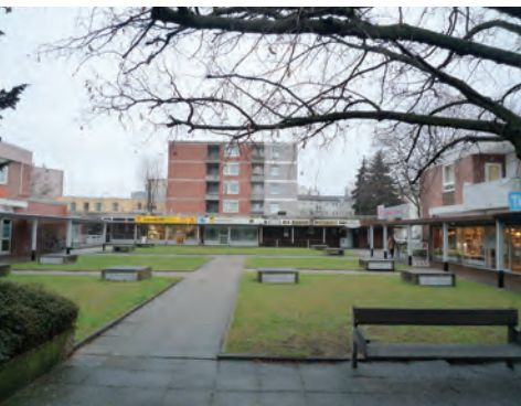
Blick vom Hochhaus am Riesentrapp in Richtung Ladenzentrum Gesemannstraße (oben). Das Ladenzentrum Gesemannstraße ist ebenfalls sanierungsbedürftig, hat aber gute Chancen als Nahversorgungsstandort zu überleben.
