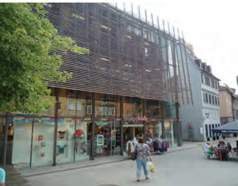
Das ehemalige Hettlage-Haus in Schwäbisch Hall beherbergt heute ein Bekleidungsgeschäft im Erdgeschoss und in den Obergeschossen die Stadtbibliothek.
