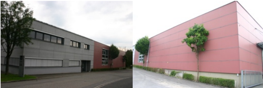
Abbildung 85 Lagerhalle, Staudachstr. 3, 1995, Christian Lenz
