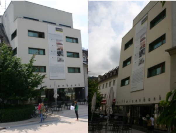
Abbildung 67 Bankfiliale, Kornmarktstr. 14, 1997, Carlo Baumschlager, Dietmar Eberle
