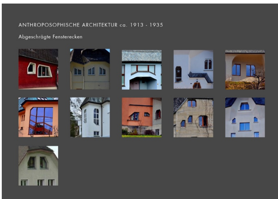
Abbildung 221 Formal ähnliche Ausprägung der abgeschrägten Fenster, Seminararbeit Universität Stuttgart.
