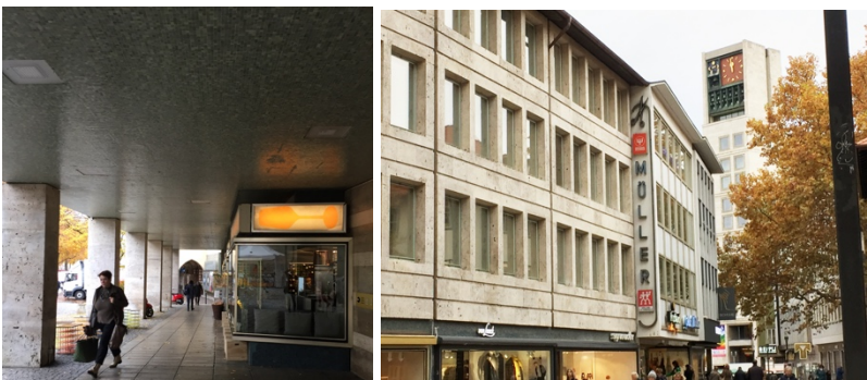
Abbildung 124 Fassade in der Kirchstraße, rechts, eigene Fotografie
