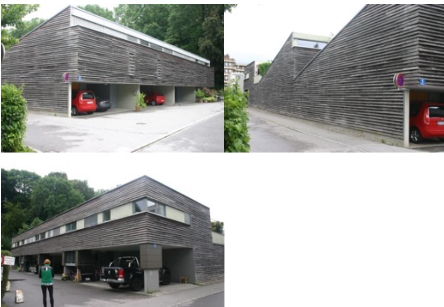
Abbildung 61 Wohnanlage, Eragasse 5, 1994-96, Theo Lang, Karl Schwärzler
