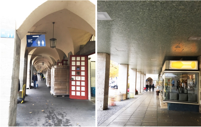
Abbildung 128 Pfeiler Kolonnaden "König von England", rechts, eigene Fotografie
