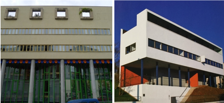
Abbildung 139 Le Corbusier Haus 14, Weißenhofsiedlung, Foto: "Die Weißenhofsiedlung von Manfred Ulmer und Jörg Kurz, Hampp Media GmbH, Stuttgart, 2006, S: 94, rechts
