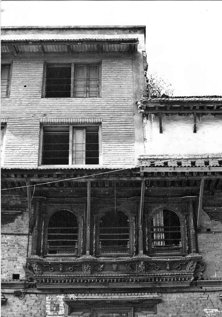
Abb. 48: Teilung und Aufstockung eines Altbaus über dem 1. Obergeschoss.
