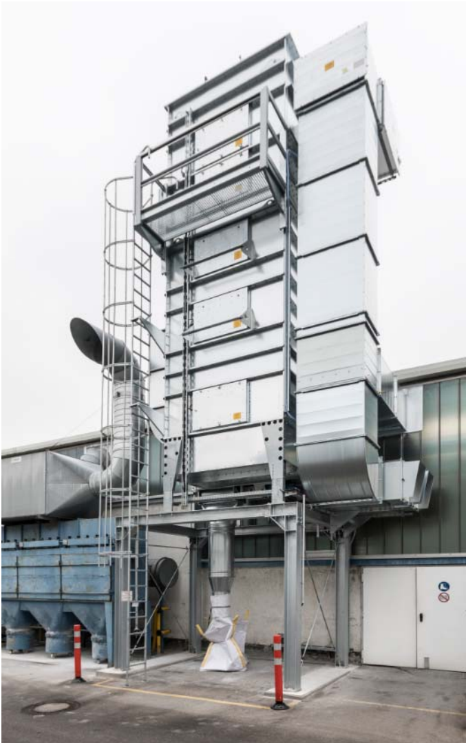
Entstauber mit Prozessluftrückführung
