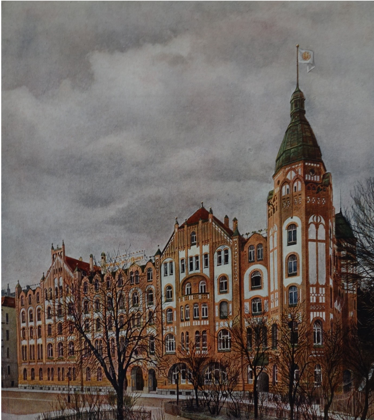
Abb. 83 Ehemaliges CVJM-Vereinsheim in der Furtbachstraße 6
