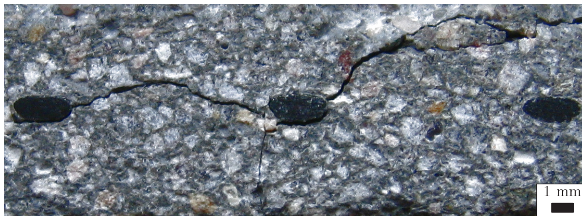
Abbildung 1.2: Rissbildung in textilverstärktem Beton
