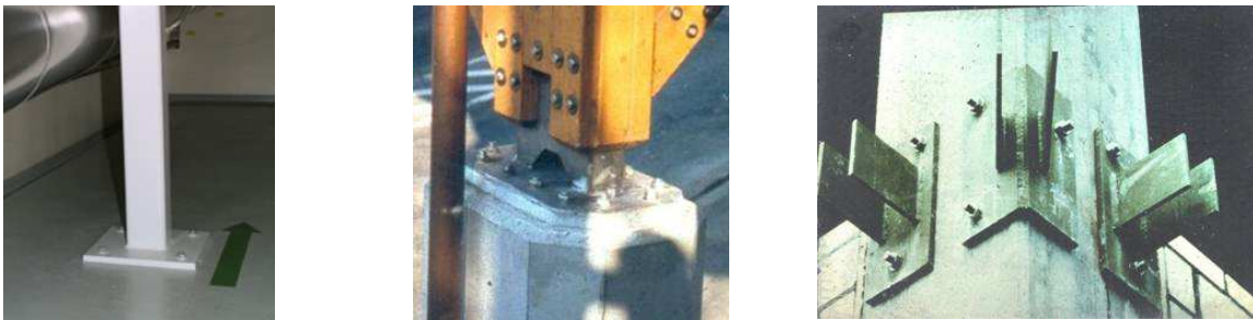
Bild 1.1 Anwendungsbeispiele für Verbunddübel, verankert in Beton
