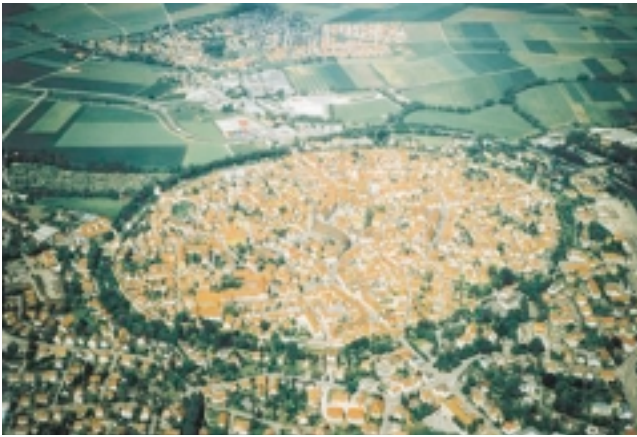
Abb. 4: Die Stadt Nördlingen wurde in den Rieskrater hineingebaut.
