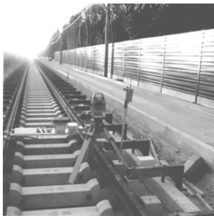
1) Absteckung der Gleisgeometrie (Bildquelle: GEoid 1998)
