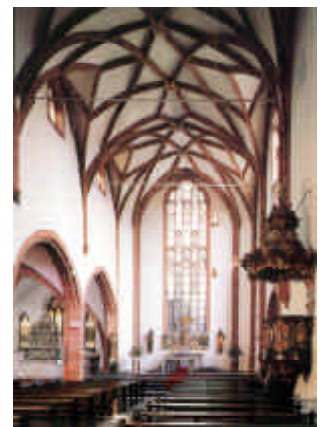
157, 158 Innenraum von St. Antonius in Trier, vor der Zerstörung und nach dem Wiederaufbau.
