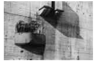
113 Detail von der Sprengung der Aussenmauer, 1948
