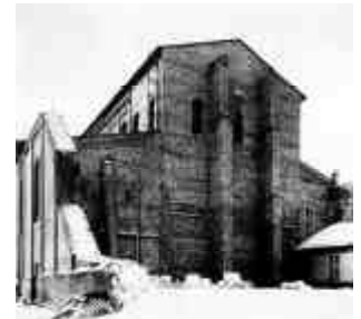
146 Neuerrichtete nördliche Giebelwand von St. Bonifaz.
