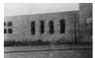
115 Bunker nach Sprengung der Öffnungen, um 1948
