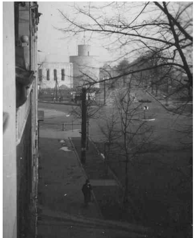
116 Blick auf den „Handweiser“ und den Bunker nach den Sprengarbeiten.
