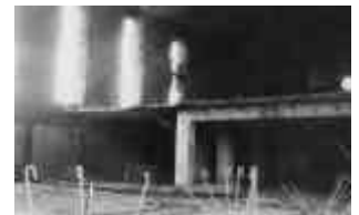
114 Blick in den Innenraum des Bunkers nach den Sprengarbeiten.
