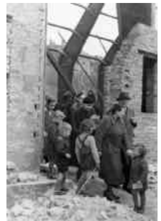
72 Gemeindeglieder der Offenbarungskirche in Berlin beim Verlassen der Baustelle nach dem Richtfest.
