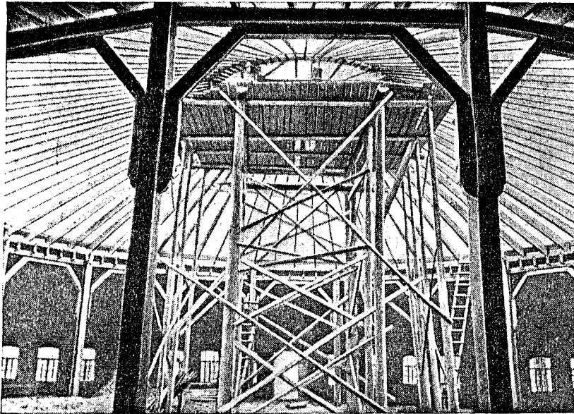
Abb. 12. Šuchovsches Kuppel-Holzdach aus Brettern, die auf einer Rippe aufliegen.
