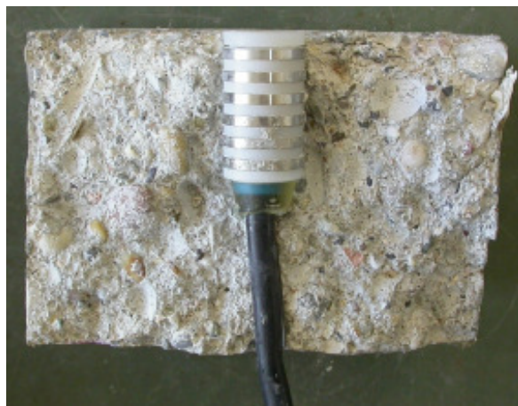
Foto einer einbetonierten Multi-Ring-Elektrode nach dem Spalten des Prüfkörpers
