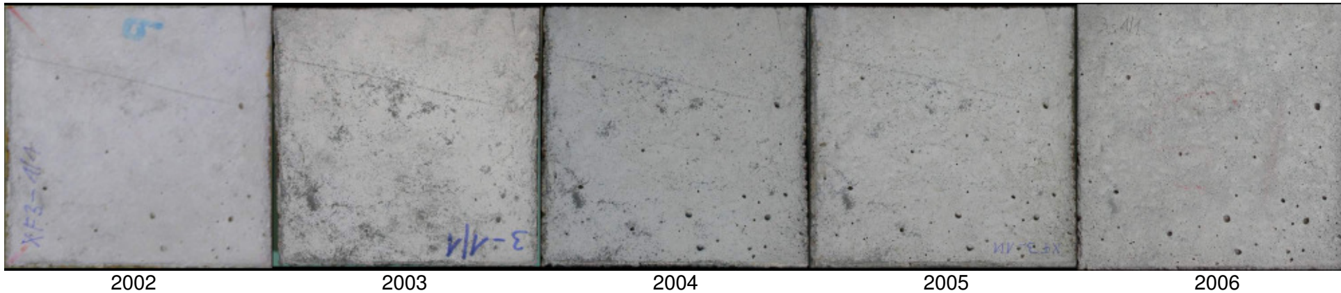
Bild 59: Bildserie der Prüffläche des Probekörpers XF3-1/1 nach der Herstellung (2002) und im Frühjahr der Jahre 2003 bis 2006.
