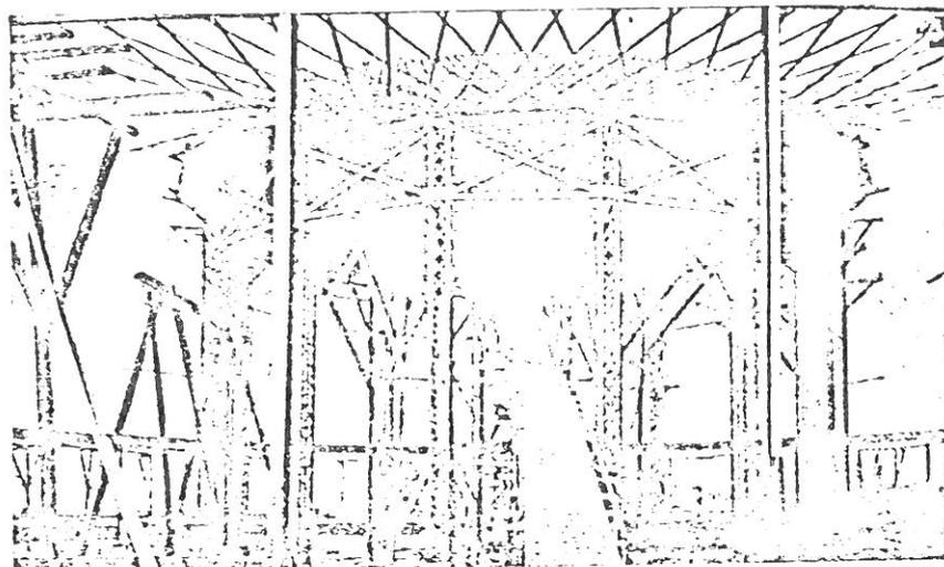
Abb. 2. Netzförmiges Hängedach des runden Ausstellungspavillons auf der Ausstellung in Nižnij Novgorod (1895) während des Baus
