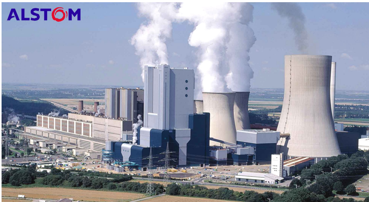
Bild 2.3: Luftaufnahme des BoA-Blocks, Kraftwerk Niederaußem
