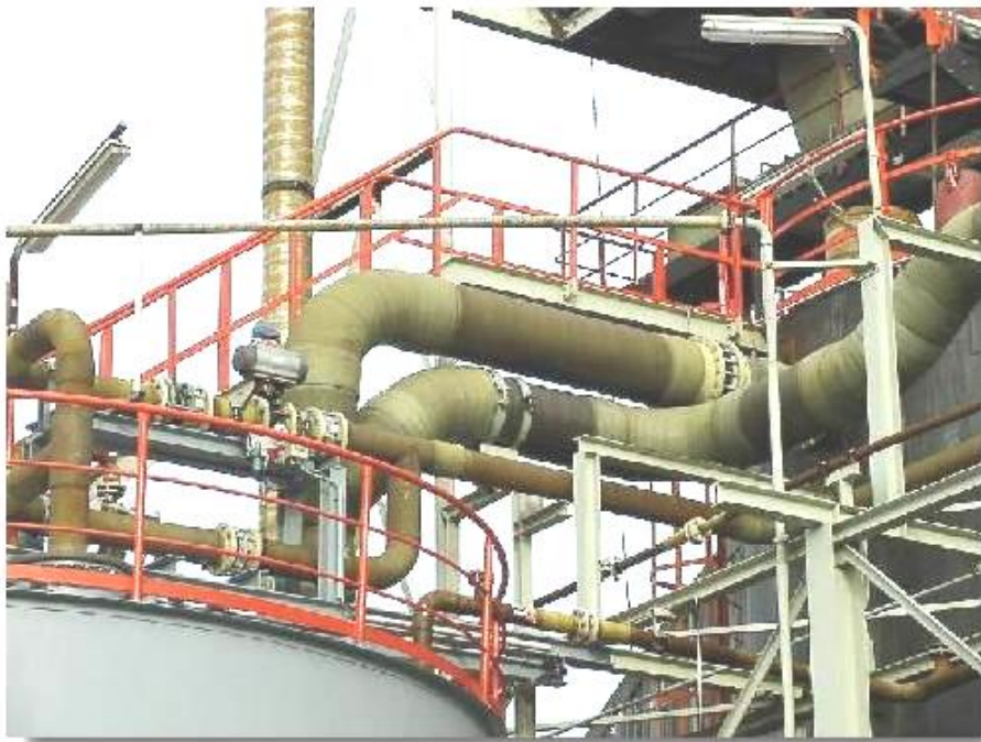
Bild 1.1: Chemische Anlage mit Rohrleitungen und Flanschen aus GFK Quelle: Neßler GmbH
