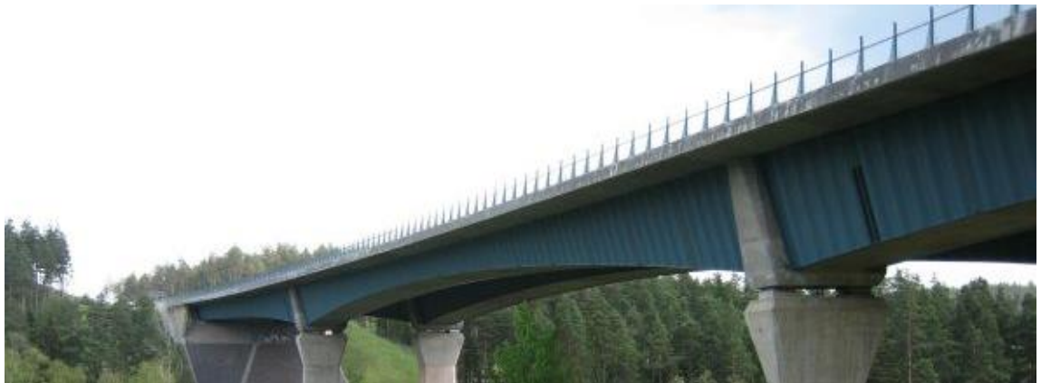
Bild 6.12: Ansicht Talbrücke Altwipfergrund
