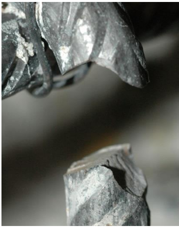
Bild 4.20: Bruch der Bewehrung an Körper QE1/2
