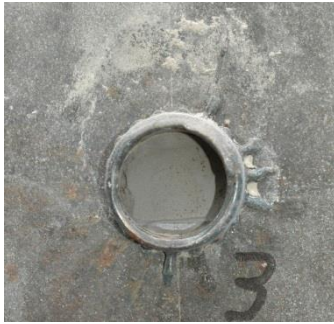
Bild 4.14: Sehr geringe Betonzerstörung am Beispiel von Körper QE3/8 - Stahlseite
