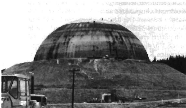
Bild 14. Die in Bild 13 dargestellte Schalung während des Betoniervorgangs
