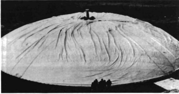
Bild 18. System Bini: Die Schalung wird durch Luftüberdruck hochgehoben.
