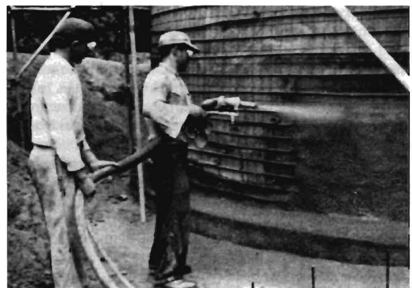
Bild 12. Verfahren nach Neff: Torkretieren auf die Außenseite der Schalung
