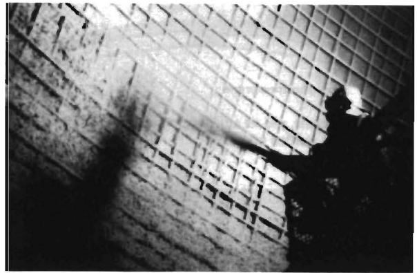
Bild 15. Die erste Lage des Betons ist aufgebracht
