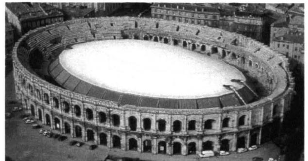
**Bild 1.** Die Überdachung der Arena in Nîmes. Luftaufnahme unmittelbar nach der ersten Montage im Dezember 1988
