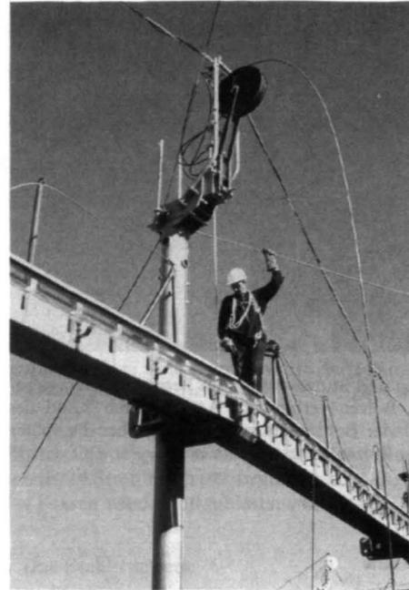
Bild 15. Das Heben des Druckringes
