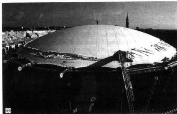
**Bild 17 a–e.** Heben des Kissens; **a** Durch die abgeknickte Form der Auslegerträger wird das Einklinken des Kissens auf der Piste vereinfacht, **b** Nach ca.  $\frac{1}{3}$  des Hubweges, **c** Nach ca.  $\frac{2}{3}$  des Hubweges, **d** Erst in der letzten Phase des Hebevorganges verliert das Kissen den Bodenkontakt. Die 4000 m<sup>2</sup> große Membranfläche schwebt jetzt wie ein Segel, **e** Das Kissen unmittelbar nach dem Aufblasen
