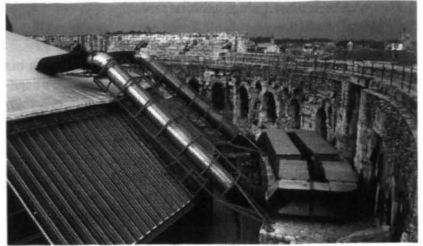
**Bild 8.** Ansicht der Gebläseanlage mit den Zuluftrohren. Die gesamte Anlage ist in Komponenten zerlegbar. Sie wird mit der Überdachung in die Arena ein- bzw. ausgebaut
