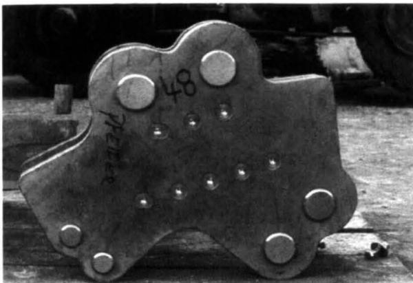
**Bild 12.** Einer der (Ringseil-)Knoten, die den orthogonalen inneren Teil des Seilnetzes mit dem Ringseil und den Radialseilen verbinden
