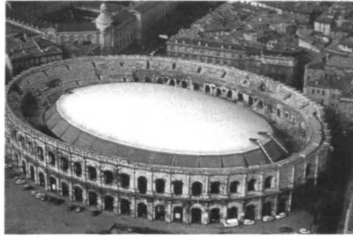
Bild 2. Saisonale Überdachung (Oktober bis März) der römischen Arena in Nîmes. Sie steht in dieser Zeit als vielbegehrter Veranstaltungsort zur Verfügung. Die Überdachung erfolgt stützenfrei mit einem Luftkissen über eine Spannweite von 60 x 90 m.
