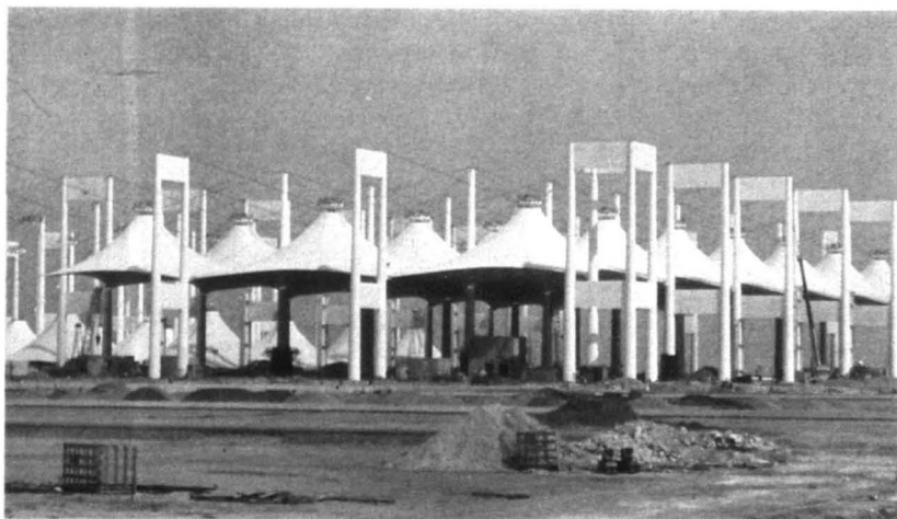
Bild 1. Das Hajj-Terminal auf dem Flughafen in Jeddah in Saudi-Arabien ist eine der größten überdachten Flächen der Welt; die Zeltkonstruktion besteht aus teflonbeschichtetem Glasfasergewebe.
