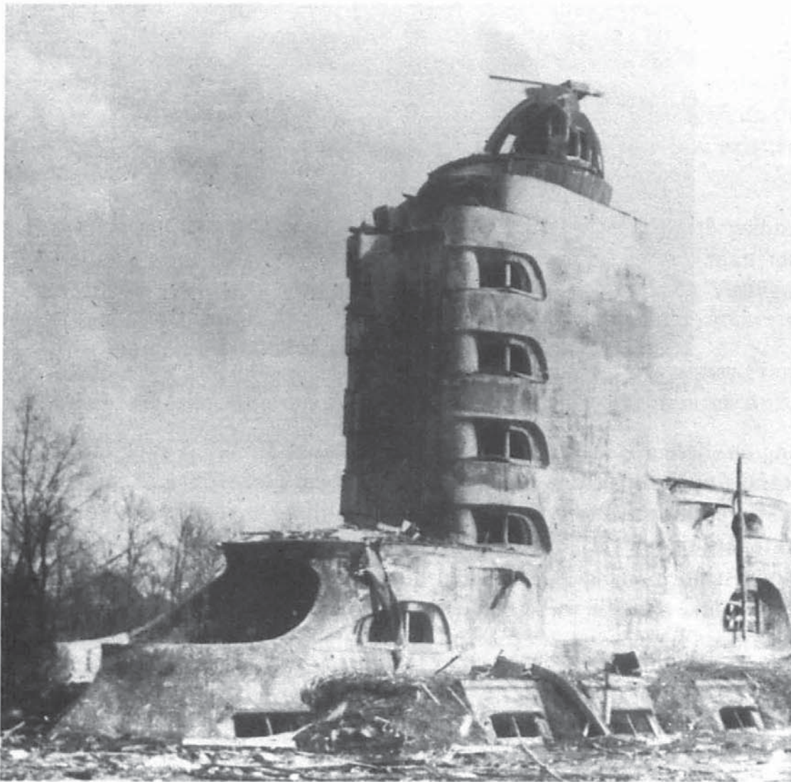
Abb.28 Der Einstein-Turm am Ende des Zweiten Weltkrieges, schwer beschädigt durch eine in der Nähe explodierende Luftmine. Abb. aus KJ.
