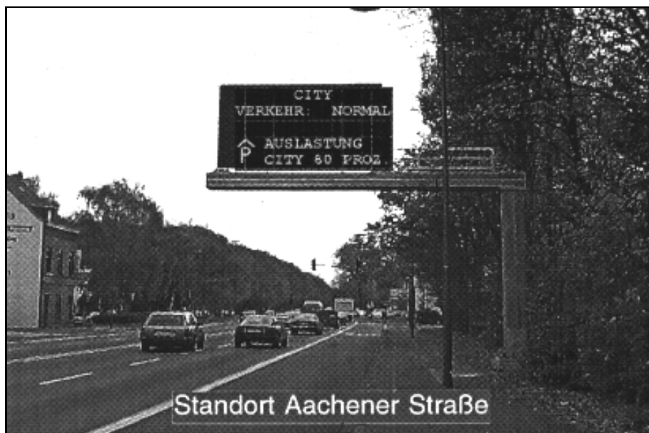
Abbildung 5.1: Eine Wechselanzeige des Verkehrsleitsystems der Stadt Köln
