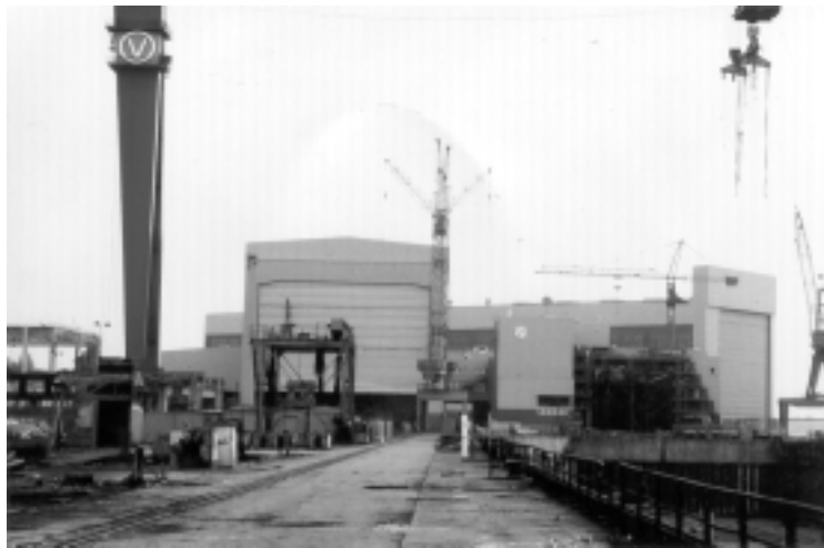
Abb. 38: Schiffsbauhalle (derzeit zwischengenutzt)
