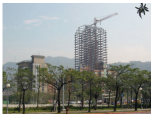
Abb. 373 Stahlrahmen von „Polaris Garden“ (TP 02) im Bau.
