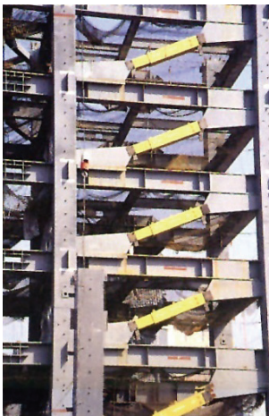
Abb. 216 The Palace: VEM-Dämpfer
