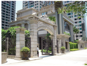
Abb.347 Haupteingang mit Pfortner von „The Palace“ (TP 03)
