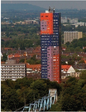
Abb. 28 Das Herkules Hochhaus, Köln, Höhe 102 m, Baujahr 1969
