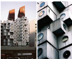
Abb. 23 Nakagin Capsule Tower: um zwei Erschließungskerne sind 140 Wohn- und Büro Module auf 11 und 13 Stockwerke montiert.
