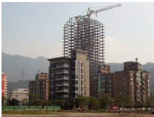
Abb. 202 Polaris Garden: Stahlrahmen Tragwerk im Bau 2006
