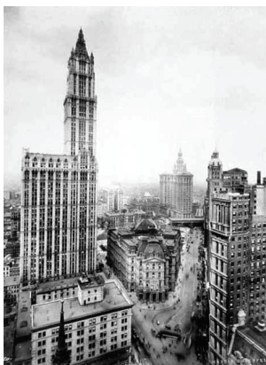
Abb. 14 Woolworth Building Verstärkung der Fundamente New York City, Baujahr 1908
