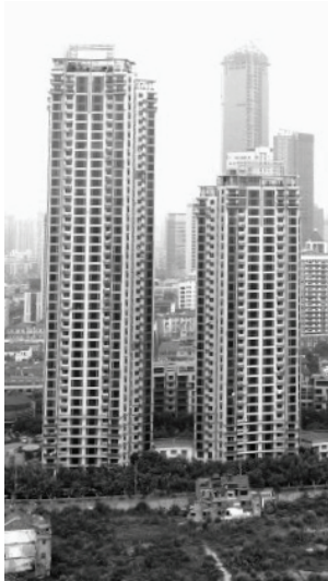
Abb. 176 The Summit Building V, Shanghai Höhe 145 m, Baujahr 2003
