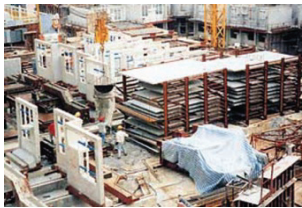
Abb. 35 Lageplatz für vorgefertigte Bauteile auf der Baustelle eines Wohnhochhauses
