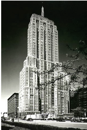
Abb. 5 Palmolive Building, Chicago, Höhe 172 m, Baujahr 1929, Umnutzung am Jahr 2002
