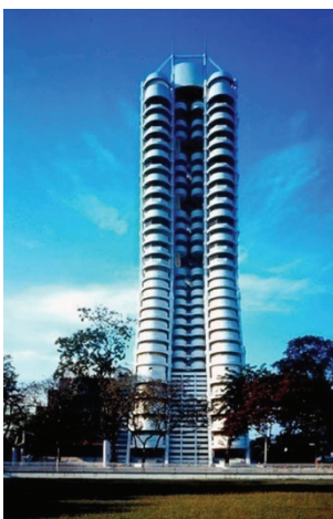
Abb. 43 MBF Tower, Pulau Pinang, Höhe 111 m, Baujahr 1993
