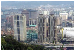
Abb. 196 Die Wohnanlage Polaris Garden befindet sich in der Xin-Yi Planungszone
