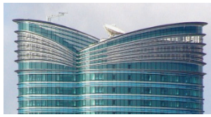
Abb. 376 Ein Flüssigkeitstilger befindet sich unter dem Dach von Highcliff (HK 03).
