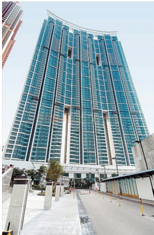
Abb. 139 The Harbourside: Öffnungen auf der Ansicht lässt Wind durch.
