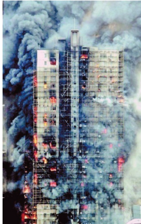
Abb. 116 Brandfall in den Jiaozhou Apartments am 15.Okt.2010, 58 Einwohner kamen ums Leben.
