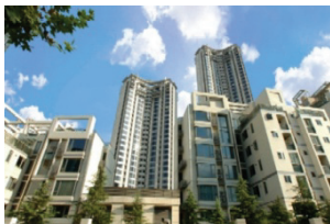
Abb. 177 The Summit Building V befindet sich in einer Wohnanlage mit verschiedenen Gebäudetypen
