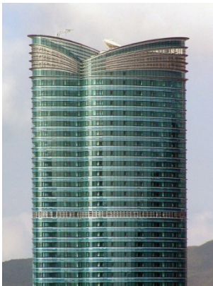
Abb. 149 Highcliff: Das Dämpfersystem gegen Gebäudeschwankung befindet sich am oben des Gebäudes.
