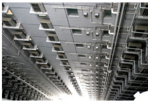
Abb. 140 The Harbourside: Schächte für Rohrleitungen und Klima-Aussenanlagen besorgt auch Licht und Luft
