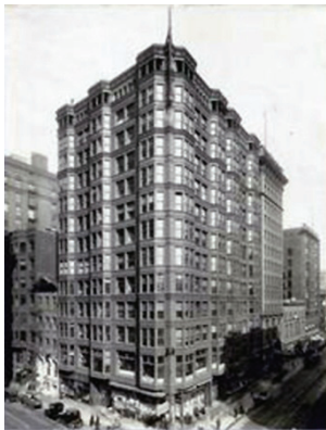
Abb. 13 Das Tacoma Building Nieten statt Schweißen Chicago, Baujahr 1886
