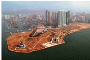
Abb. 229 Union Square in vierte Bauabschnitt, 2004.
