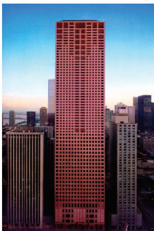
Abb. 40 Olympia Centre, Chicago, Höhe 221 m, Baujahr 1986
