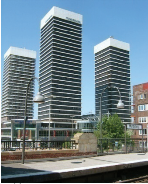
Abb. 30 Mundsburg Turm, Hamburg, Höhe 101 m, Baujahr 1973
