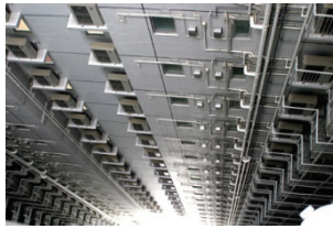
Abb. 363 Ein offener Lichtschacht im Wohnhochhaus „The Harbourside“ (HK 02)
