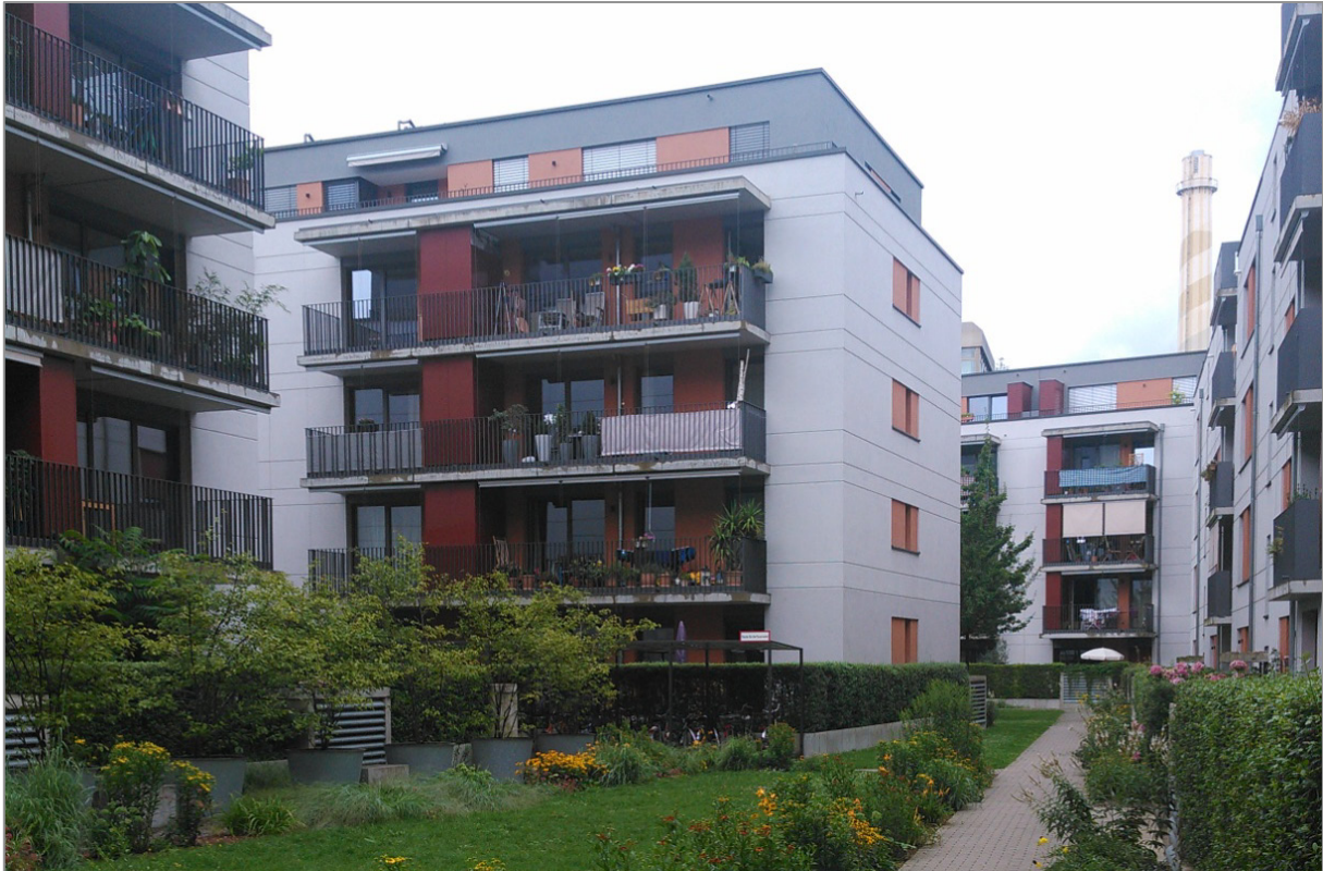
Abbildung 23: Neue Blockrand- und Innenhofbebauung der Gutenberghöfe auf dem ehemaligen Gelände der Heidelberger Druckmaschinen AG im Stadtteil HD-Bergheim (eigene Aufnahme)
