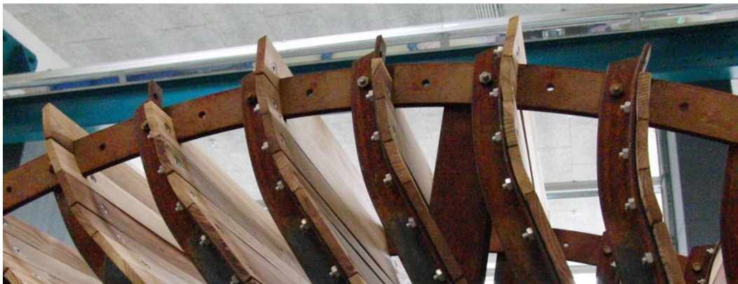
Abbildung 57 Wasserrad nach der Demontage der äußeren Latte jeder zweiten Schaufel
