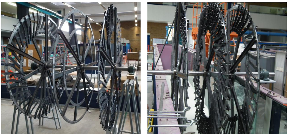
Abbildung 22 Stahlelemente des Modells: links - Aufbau außerhalb der Rinne, rechts - Installation in der Rinne
