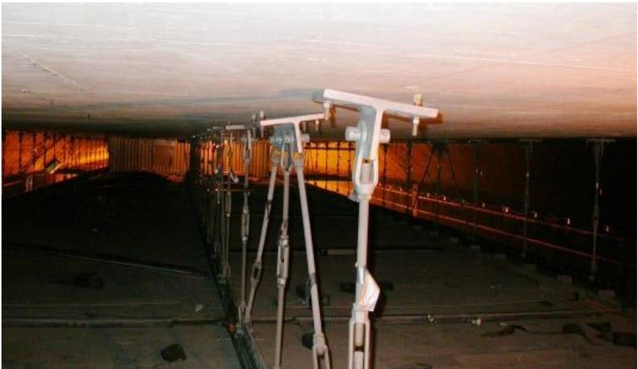
**Abbildung 1.1:** Dübelverschiebungen unter Dauerlast im Ted-Williams-Tunnel / Interstate 90 Connector Tunnel (Foto entnommen aus dem Unfallreport NTSB/HAR-07/02 des National Transportation Safety Board, 2007)
