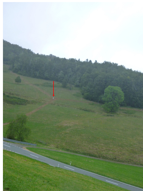
(d) SNS4, ausgestattet wie die unterirdischen Stationen. Die frischen Gräben der Kabel für die Satellitenseismometer sind sichtbar.
