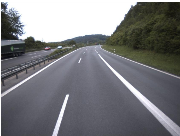
Abbildung 31: Sicht in Rechtskurve R=800m bei Lorch (östl. B 297)
