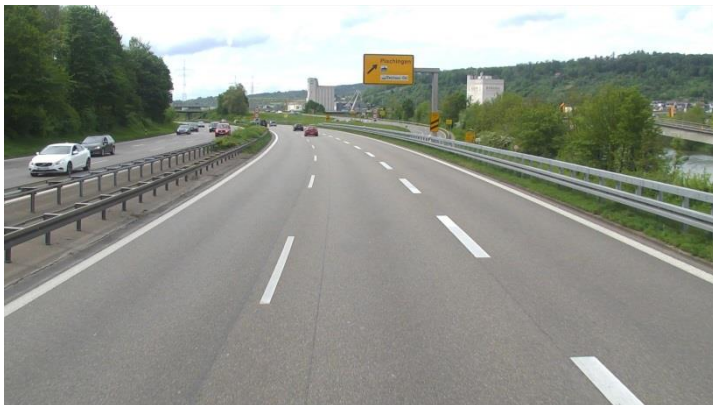
Abbildungen 3a und 3b: Radius R=400 m auf B 10 bei Plochingen
