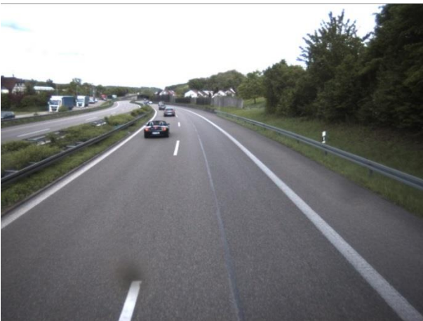
Abbildungen 23 und 24: Radius R=600 m auf B 10 bei Ebersbach
