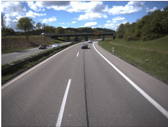
Abbildungen 16 und 17: Radius R=600 m auf B 27 bei Kirchentellinsfurt
