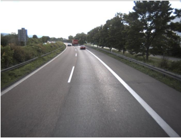
Abbildungen 21 und 22: Radius R=600 m auf B 29 bei Remshalden
