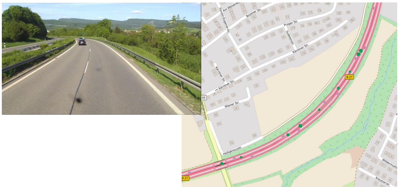
Abbildungen 14 und 15: Radius R=600 m auf B 27 bei Hechingen
