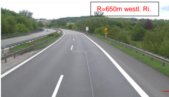
Abbildungen 18, 19 und 20: Radienfolge R=600 m/ R=650 m auf B 10 bei Göppingen
