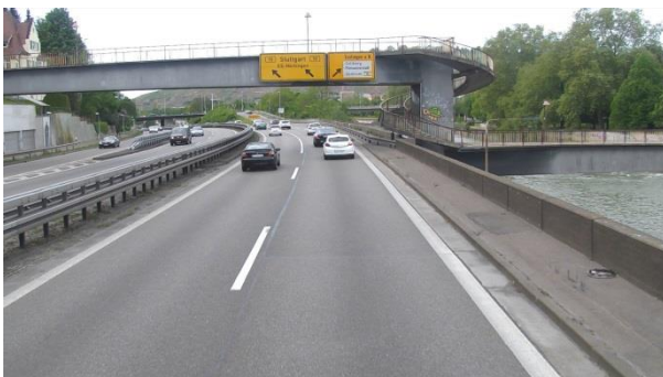
Abbildungen 6 und 7: Radius R=500\text{ m} auf B 10 bei Esslingen-Mitte
