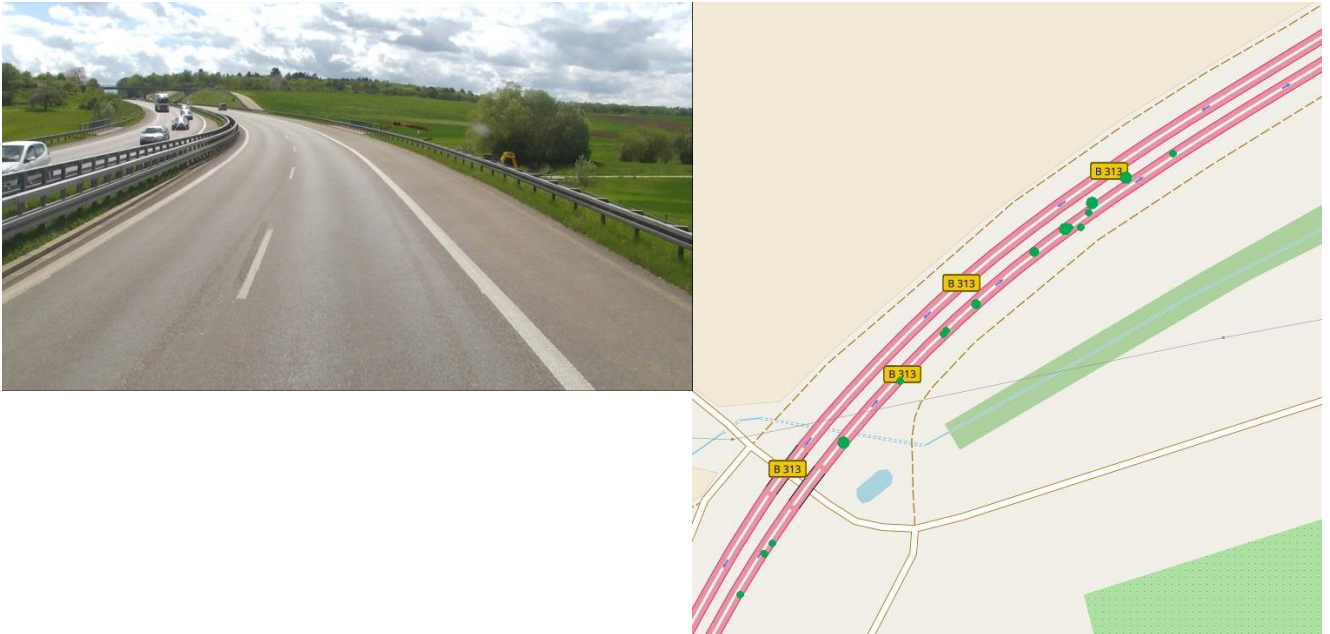
Abbildungen 12 und 13: Radius R=550 m auf B 313 bei Nürtingen (Zizishausen)
