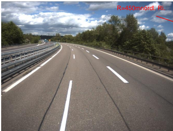
Abbildungen 4 und 5: Radius R=450\text{ m} und R=600\text{ m} auf B 313 bei Köngen
