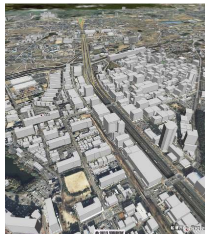
Abb. 5.59 Die Neue Stadt Senri in Osaka, Japan, Dichte und Höhe der Stadt um den Bahnhof.
