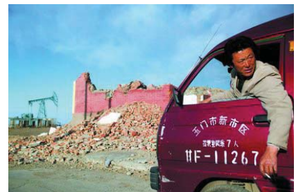
Abb. 3.23 Abriss der Stadt Yumen
