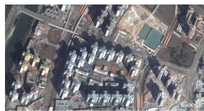
Abb. 5.60 Die Neue Stadt Tin Shui Wei (4,3 qkm, 340.000 EW geplant, 790 EW/ha). Es gibt sehr wenig Grün zwischen den Wohntürmen, die mehr als 20 Geschosse aufweisen. Alle Freiräume sind überwiegend als Verkehrsflächen und Sportplätze besetzt, teilweise gibt es Grün auf Dachterrassen.
