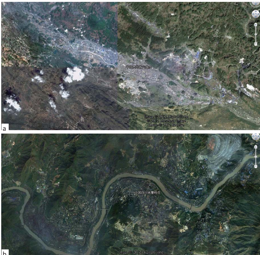
Abb. 3.20 Die neu gebauten Industriestädte in dieser Phase (a) Schwerindustrie-Stadt Liu Pan Shui, (b) Stahlwerk-Stadt Pan Zhi Hua
