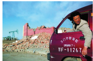
Abb. 3.23 Abriss der Stadt Yumen
