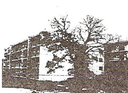
Abb. 28 Außenansicht des Gea-Myung-Wohnhochhauses
