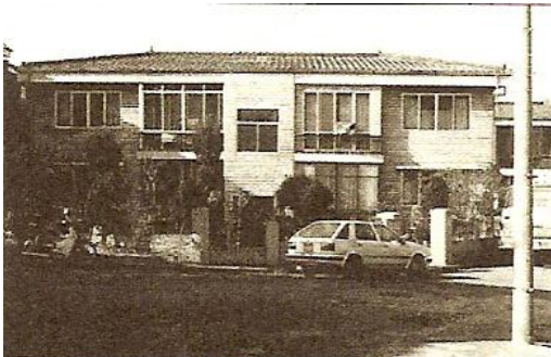
Abb. 46 Außenansicht eines Mehrfamilienhauses
