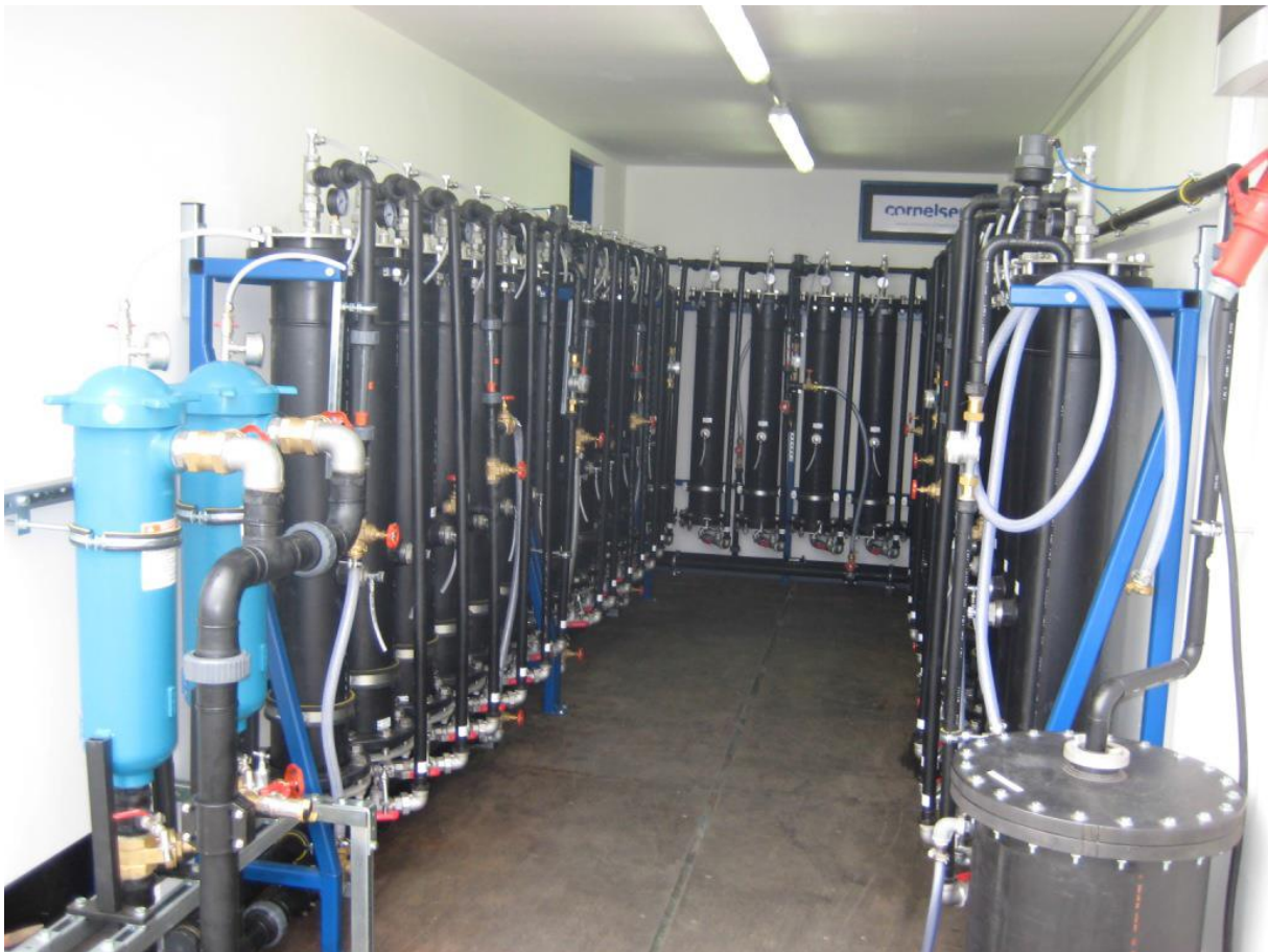
Abb. 3: Testanlage Aktivkohlebatterie am Flughafen Düsseldorf
