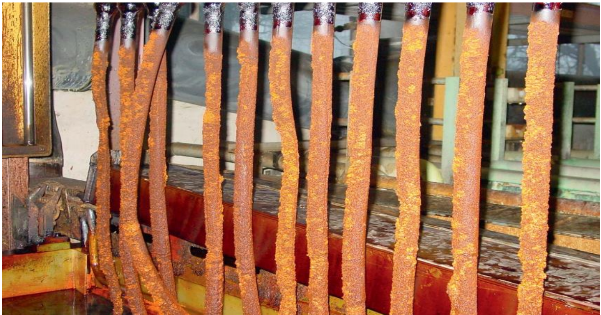
Abb. 7: Korrodierte Bleianoden nach mehrmonatigem Einsatz des Aminethoxylats (Marzinkowski et al., 2011, Wienand et al, 2015)
