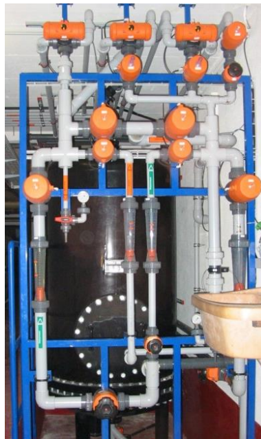
Abb. 6: Bildausschnitt des Kationenaustauschers mit Rohrbatterie, Beispiel 2
