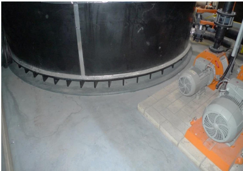
Abb.2: Beispiel: Behälter aufgeständert einsehbar
