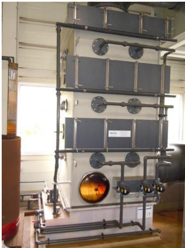
Abb. 4: Chromnebelabscheider eines Hartchromprozesses, Abluftleistung 28.000 m 3 /h
