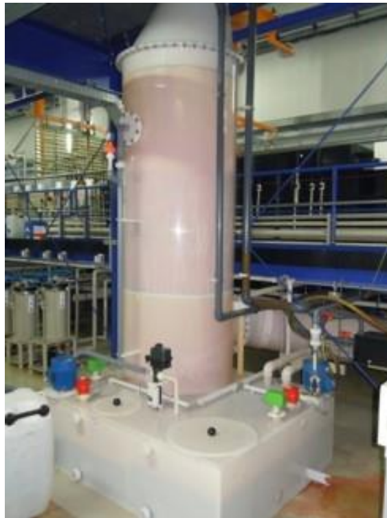
Abb. 7: Atmosphärischer Verdunstungskühler zur Chrombadkühlung, 5.000 m 3 /h, 260 kW Kühlleistung
