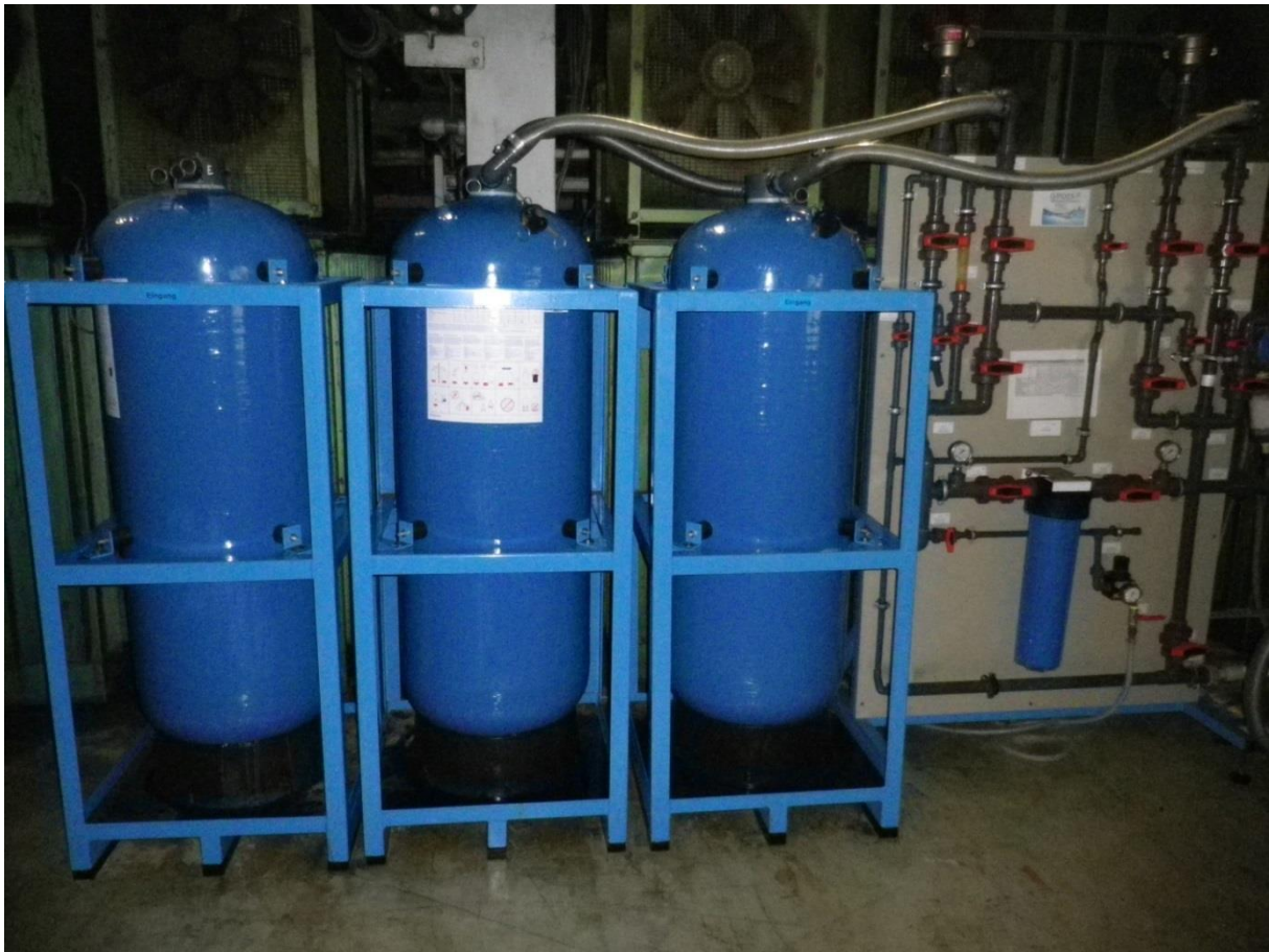
Abb. 4: Anionenaustauscher Firma MTV in Solingen
