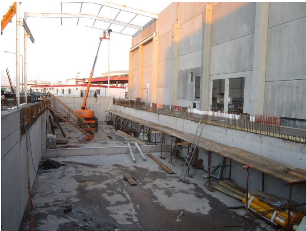
Abb.5: Beispiel: Löschwasserrückhaltung und WHG Auffangwanne im Bau Trennung sauer/ alkalisch
