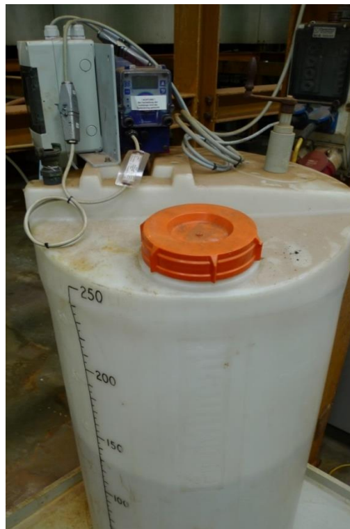
Abb.19: Dosierstation eines fluorfreien Netzmittels
