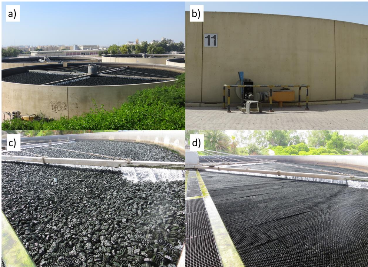
Abbildung 16: Nitrifizierende Tropfkörper auf der Al Aweer STP in Dubai (VAE): a) Nitrifikationstropfkörper mit einem 4 armigen Drehsprenger; b) Technische Belüftung des N-TK Nr. 11; c) Kunststoffschüttmaterial der Tropfkörper Nr. 1 - 6 und 8 - 15; d) Kreuzstrukturierte Kunststoffpackung des Tropfkörpers Nr. 7
