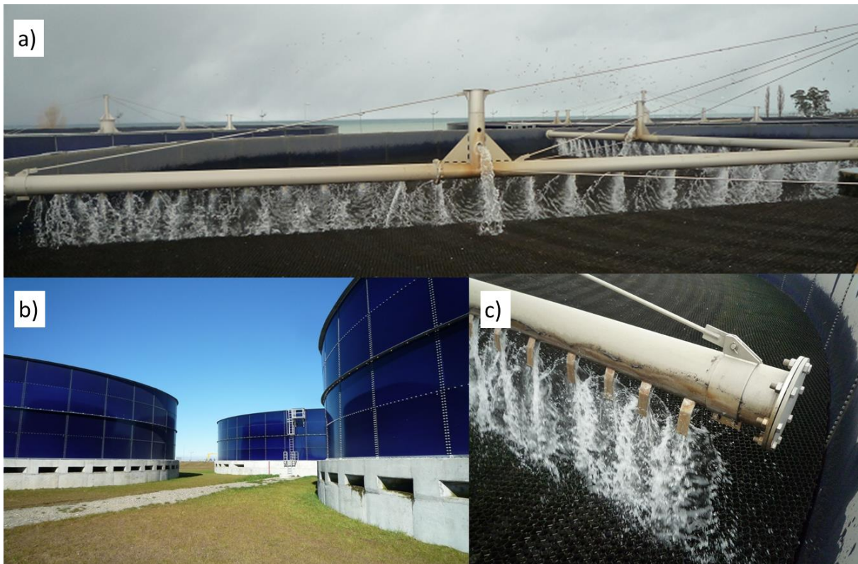
Abbildung 13: Tropfkörper der Adlia WWTP in Batumi, Georgien: a) Wasserverteilung entlang eines Drehsprengerarms (4 armige Drehsprenger); b) Tropfkörper (Umwandlung aus Kunststoffplatten und Lüftungsöffnungen im Betonfundament); c) Prallbleche vor den Öffnungen im Drehsprengerarm zur Feinverteilung des Abwassers
