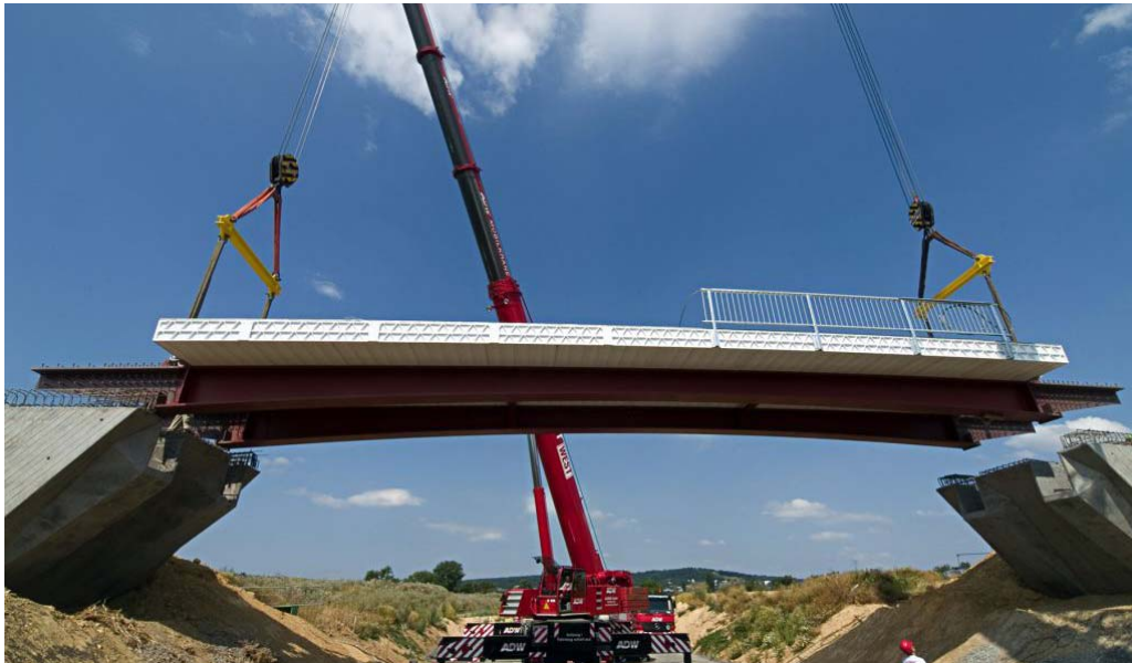
Abbildung A-1: Einbau der vorgefertigten GFK-Straßenbrücke Friedberg (Hessen)
