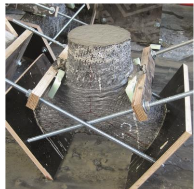
D: Tragknoten nach der Betonage
