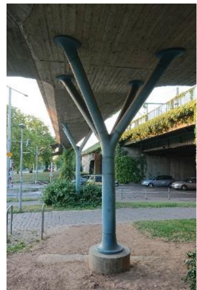
Bild 52: Verzweigte Pfeiler einer Fußgängerbrücke, Untertürkheim (1991); Stahlgussknoten
