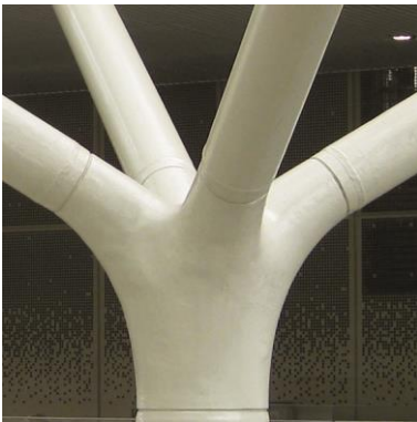
Bild 6: Konventionell hergestellte Tragknoten aus Stahl
