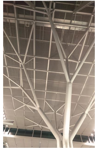
Bild 56: Verzweigte Stütze am Stuttgarter Flughafen
