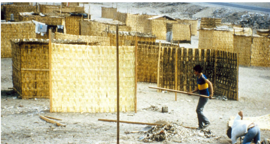
⇒ 1.17 Der Bau der ersten Bleibe auf illegal besiedeltem Gelände in Villa El Salvador, Lima. Quelle: AMHEMLIMA (2007)
