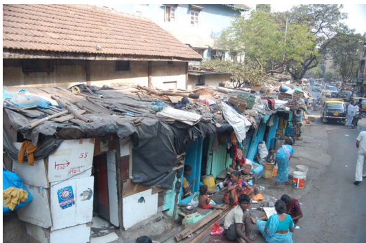
⇒ 1.7 Überall wird gebaut. Auf dem Bürgersteig gebauten Hütten in Mumbai stellen eine elementare, einfache Form Informeller Siedlungen dar. Quelle: De Maat (2010)
