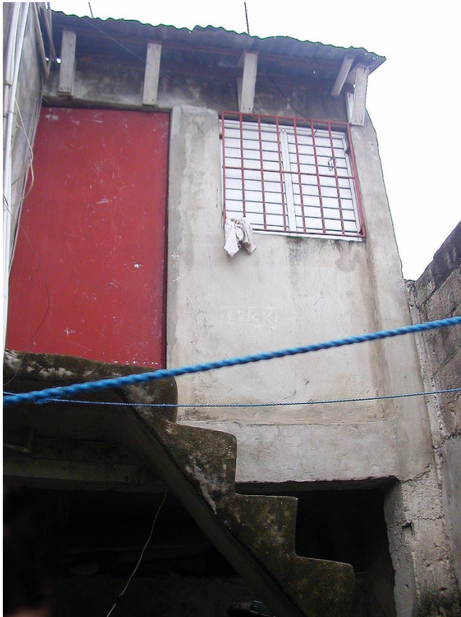
Blick auf das hintere Zimmer im 1. OG
