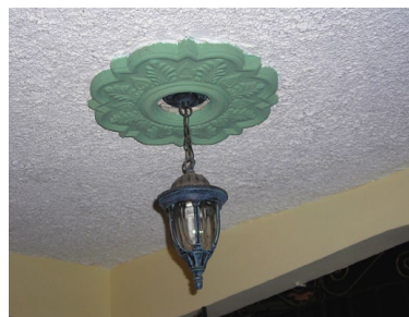
Stuckrosetten an der Decke der Galerie im 1. OG
