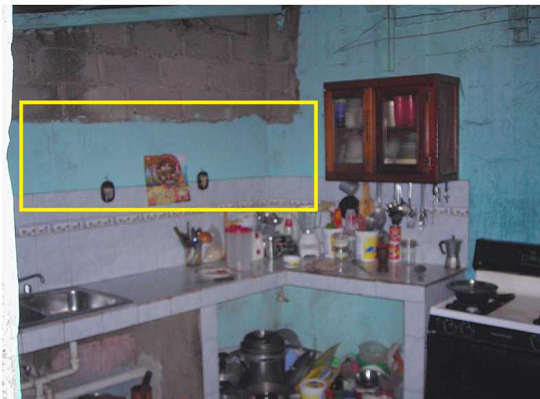
Die Küche: Verputzt wurde nur die Wandfläche, die vom Wohn- und Esszimmer einsehbar ist.
