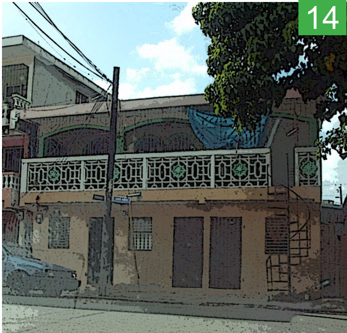
Ansicht des Hauses (2007)
