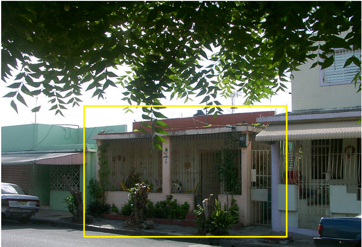
Blick von dem gegenüberliegenden Bürgersteig auf das Haus
