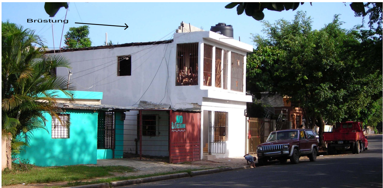
⇒8.9 Brüstungen verbergen das geneigte Dach. Quelle: Reynoso (2007)
