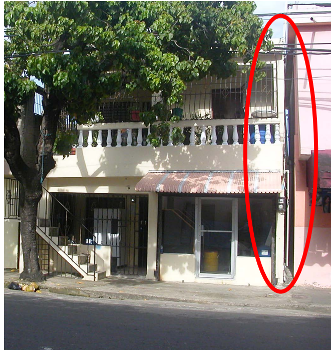
⇨ 9.8 Die Wasserleitung des Nachbarhauses liegt auf dem Grundstück des Falles 11. Quelle: Reynoso (2007)
