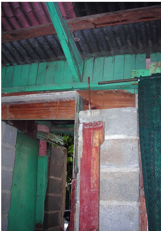
⇒8.5 Das Ersetzen der Holzwände durch Wände aus Betonsteinen. Quelle: Reynoso (2007)
