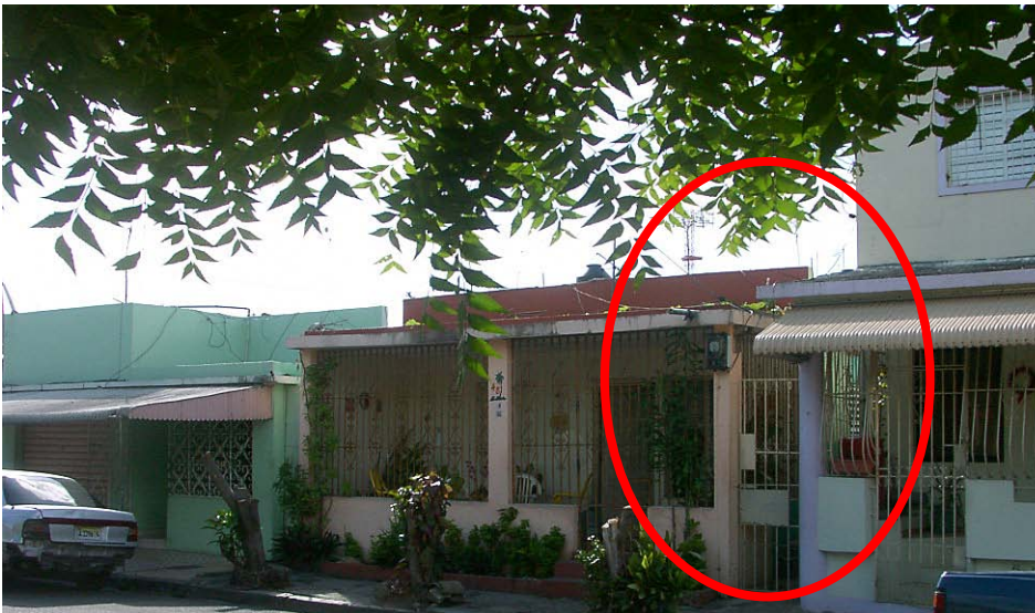
⇒9.5 Statt einer Grenzmauer ein Zwischenraum. Quelle: Reynoso (2007)
