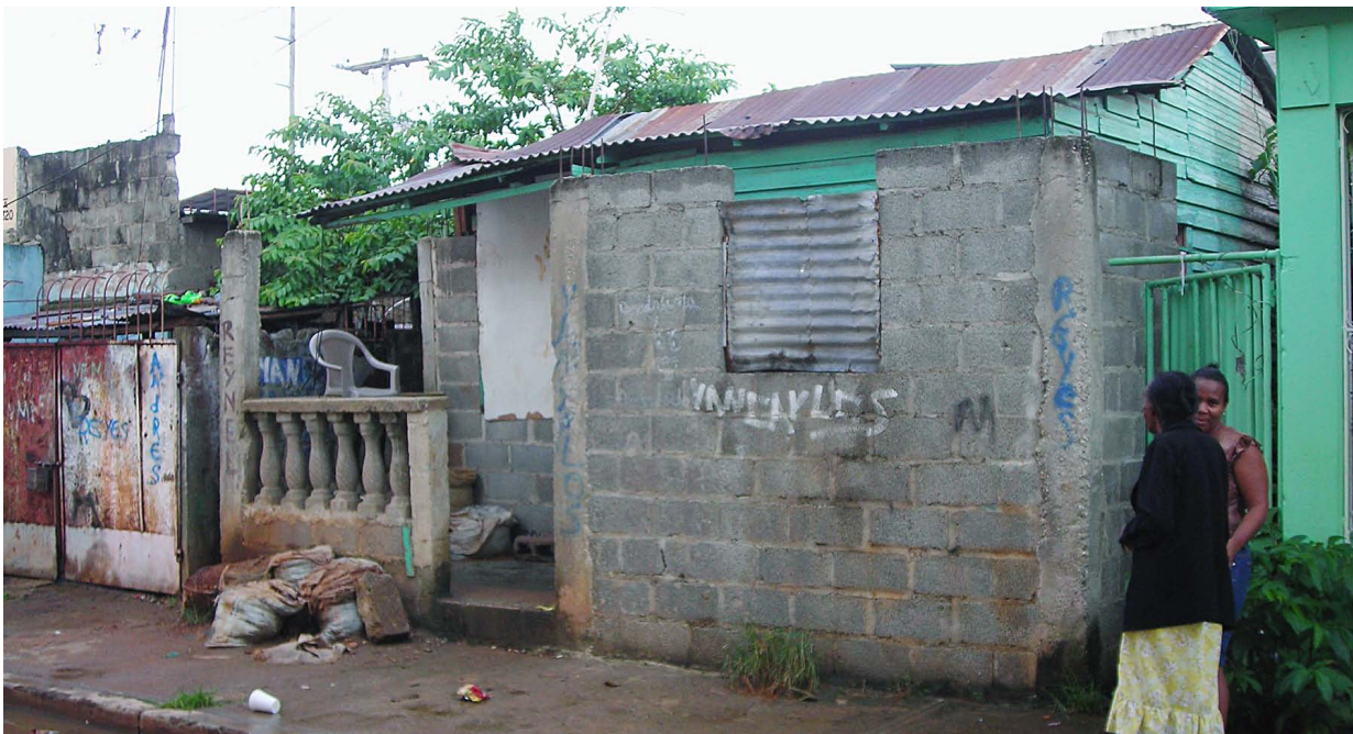
⇒8.6 Beim Ersetzen der Holzwände wird immer an der Vorderseite des Hauses begonnen. Quelle: Reynoso (2007)
