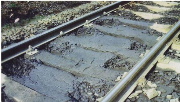
Abbildung 14: Punktuelle Instabilität im Real System [25]
