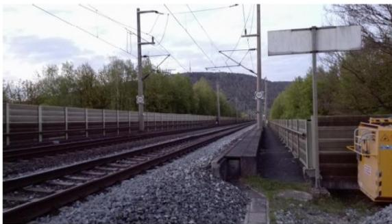
Abbildung 16: Steifigkeitswechsel am Brückenanfang und-ende im Real System [26]
