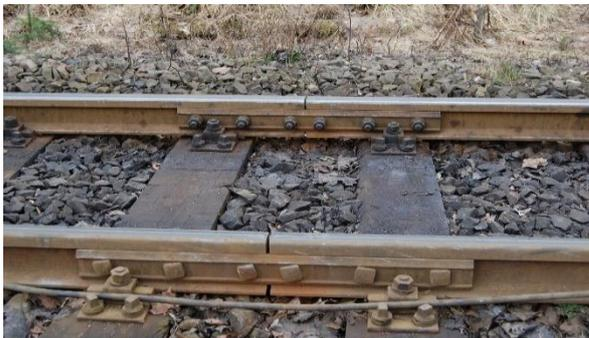
Abbildung 10: Schienenstoß im Real System [1]
