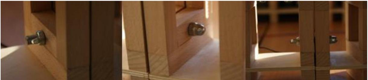
Abbildung 21: Konstruktion der Modulverbindung [24]
