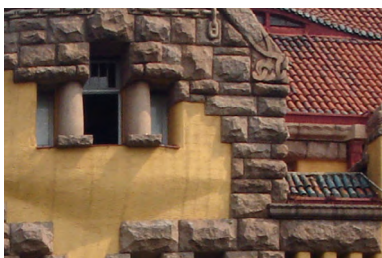
← typische Baumaterialien von der alten Gebäuden: Granit und Putz Quelle: Eigene Aufnahme, 2007
