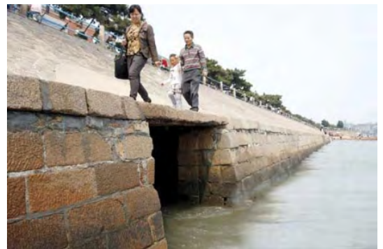
↑ Abb.024. Alter Entwässerungskanal der Kolonialzeit
