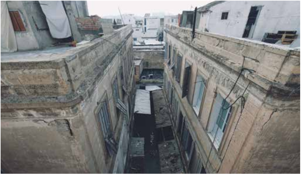
Abb. 30 Auf den Dächern informell errichtete Erweiterungen
