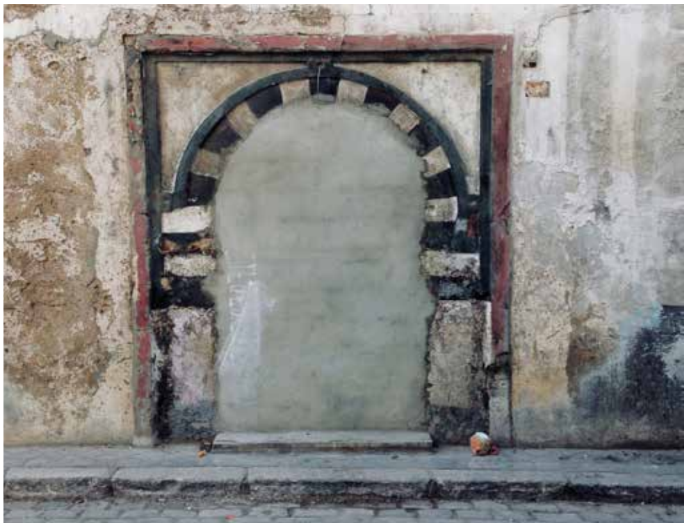
Abb. 29 Ein altes Tor, das zugemauert wurde
