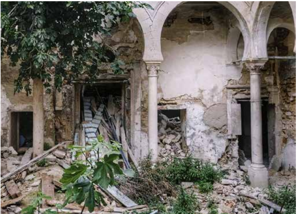
Abb. 26 Der zusammengefallene Palast Dar El Hedri in der Rue de Trésor
