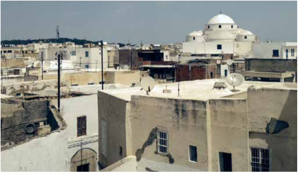
Abb. 20 Nördlicher Teil der Medina mit Blick auf die osmanische Mohamed Bey Moschee in Bab Souika
