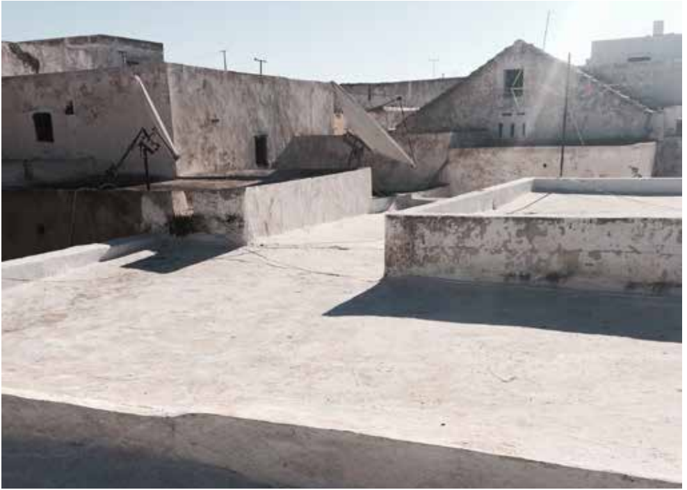
Abb. 38 Gekalkte Dachterrassen mit Satellitenschüsseln und weiterer Infrastruktur
