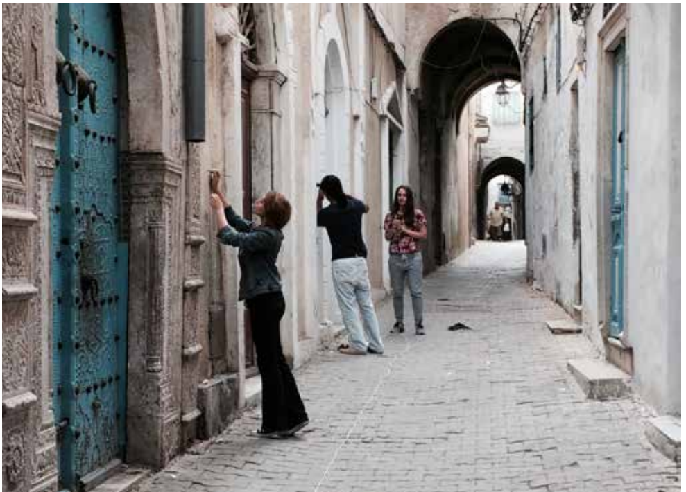
Abb. 44 Houmati Projekt Teilnehmer installieren Müllhaken in der Rue de Trésor
