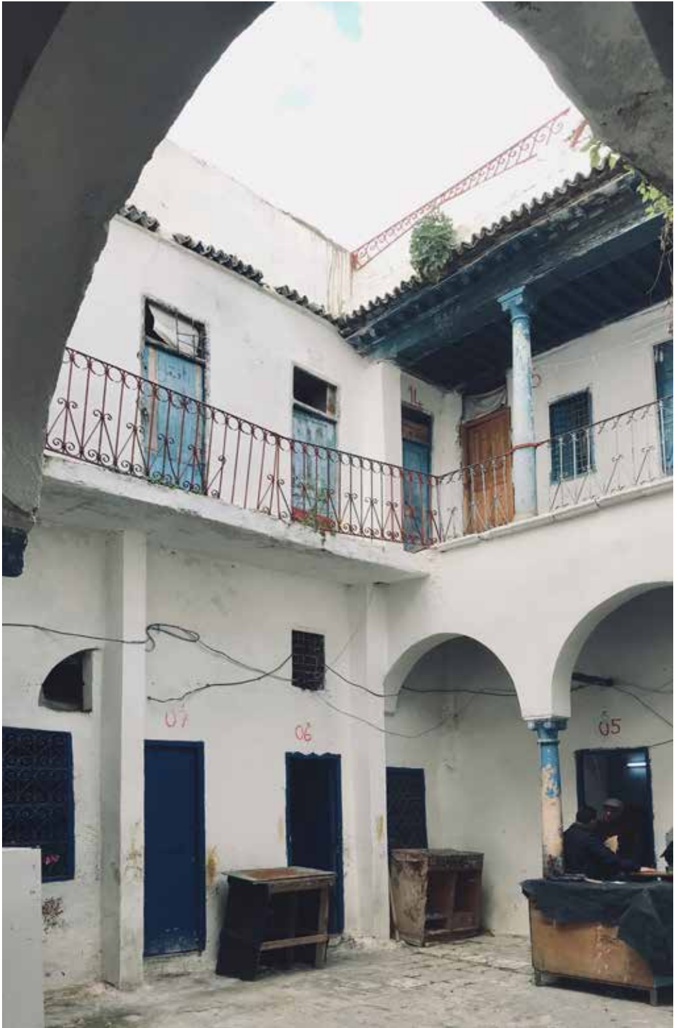
Abb. 13 Ein traditionelles Fundouk beherbergt heute verschiedene Werkstätten sowie Lagerräume
