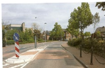
Fig. 2- 36 A raised cross-walk combined with a pedestrian refuge. (source: Bundestadt Bonn 1992, Für Bonn Tempo 30: Beiträge zur Stadtentwicklung, Stadtplanung und zum Bauwesen, p. 16)
