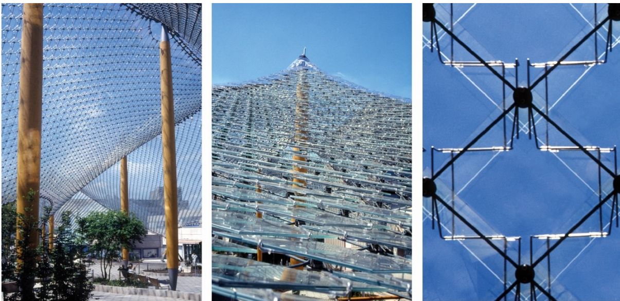
Abbildung 16: links: verglastes Seilnetz der Verbindungspromenade der Rhön-Klinik in Bad Neustadt, Mitte: Überlappung des Glasschindelsystems, rechts: Detailansicht der Glasschindeln ©Werner Sobek
