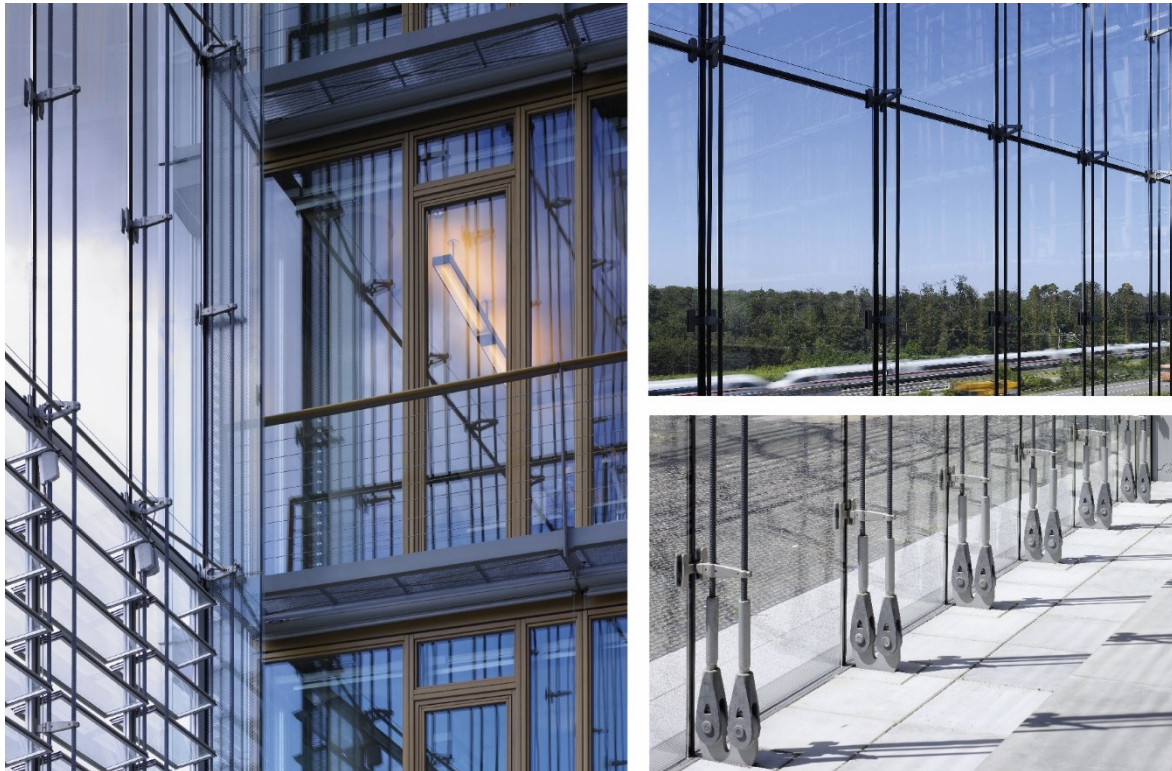
Abbildung 25: Seilfassade der Wintergärten des Lufthansaverwaltungsgebäudes © Fotografien: HG Esch, Hennef / Architekt: Christoph Ingenhoven / Ingenieur: Werner Sobek
