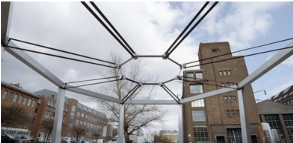
Abbildung 27: Prototyp des Ringseildachs der TU Berlin [45]
