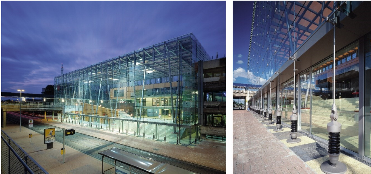
Abbildung 18: Zentraleingangsbereich der Universität Bremen, links: Gesamtansicht, rechts: Detail der Seilfußpunkte © Fotografien: Andreas Keller / Architekt: Jahn Störmer / Ingenieur: Werner Sobek
