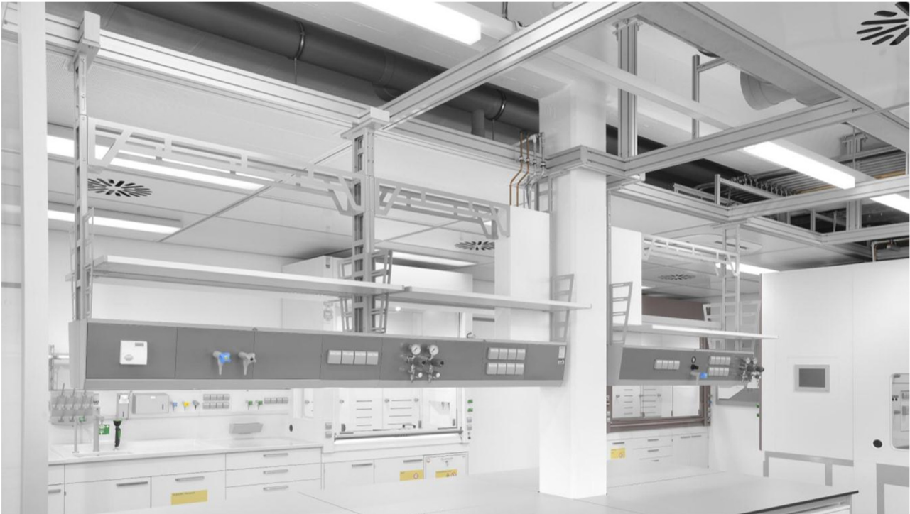
Abbildung 8: Modulares Deckensystem mit Medien- und Elektroanschlüssen 69
