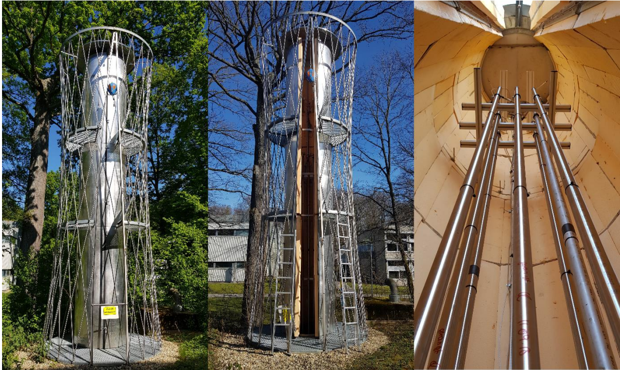
Abbildung 2.5: ATHOS-Kaminaufbau geschlossen von außen (links), der Höhe nach geöffnet (mitte) und mit Rohrbündel im Inneren (rechts)
