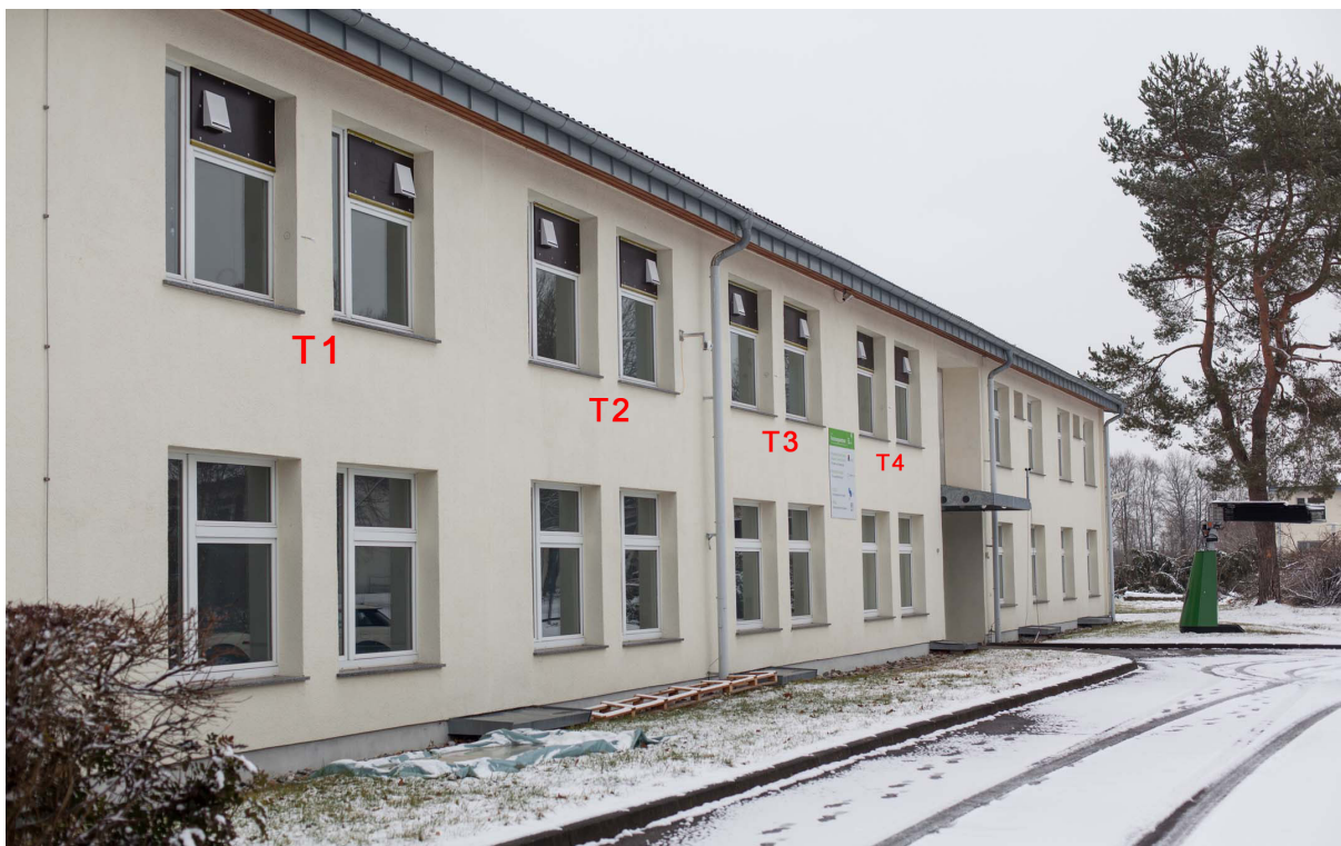
Abb. 16 Südfassade Gebäude 6 mit Einzellüfern
