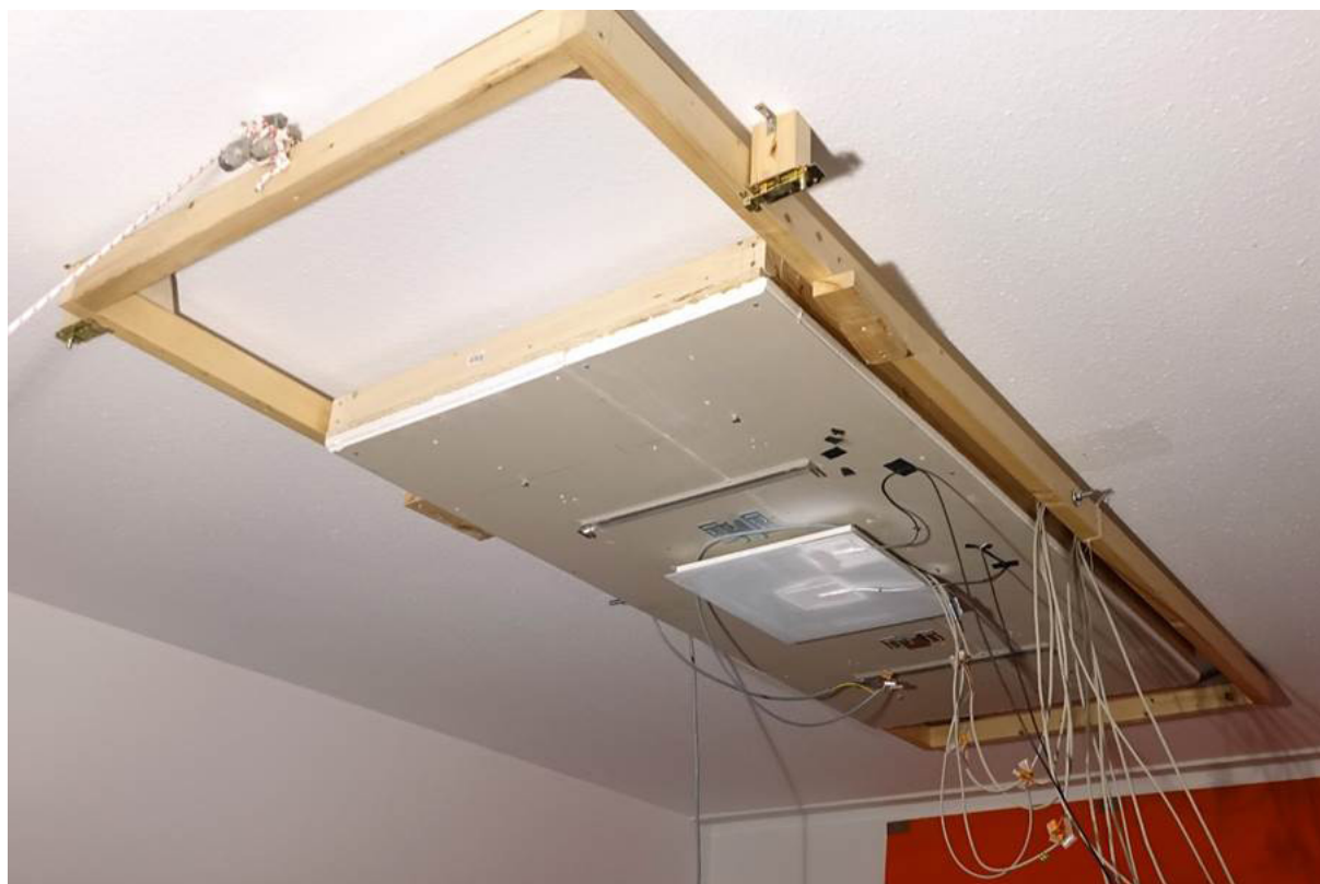
Abb. 107 Horizontale Aufhängung an der Decke
