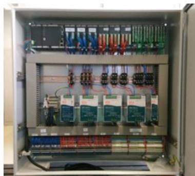
**Abb. 5.4:** Bachmann-Regelungseinheit zur Regelung der Durchbiegung und der hydraulischen Drücke
